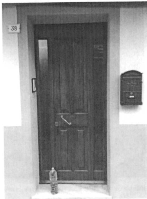
Foto n°4- Ingresso principale al civico 38
