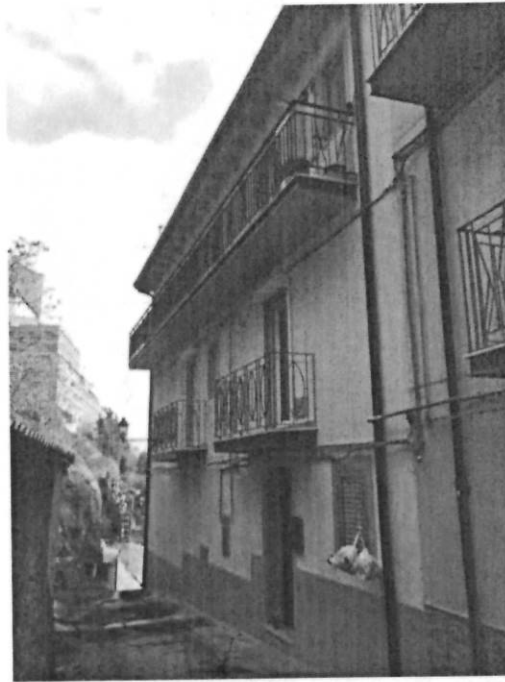
Foto n°3- Vista del prospetto principale su via delle Stelle n°38
