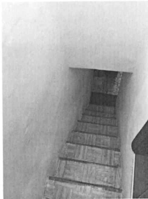
Foto n°9 – vano scala di accesso al piano seminterrato
