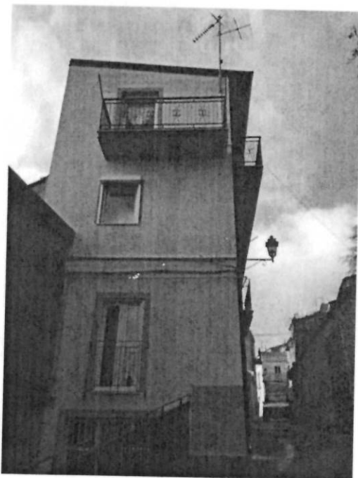
Foto n°1- Vista complessiva dello stabile da Via delle Stelle
