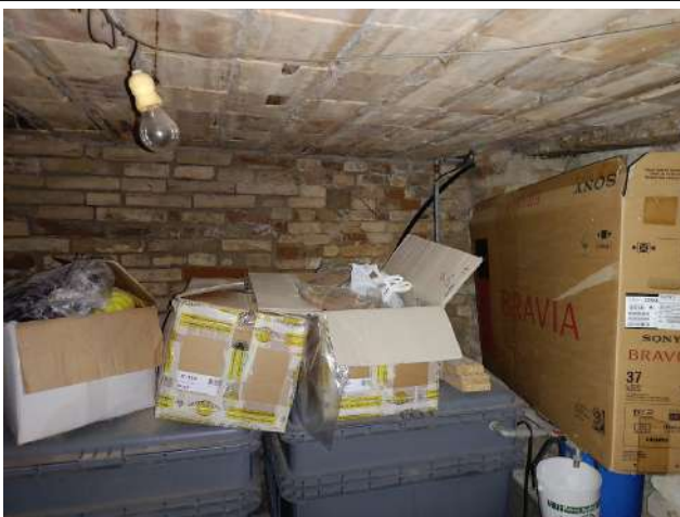
Deposito 2° livello sottostrada
