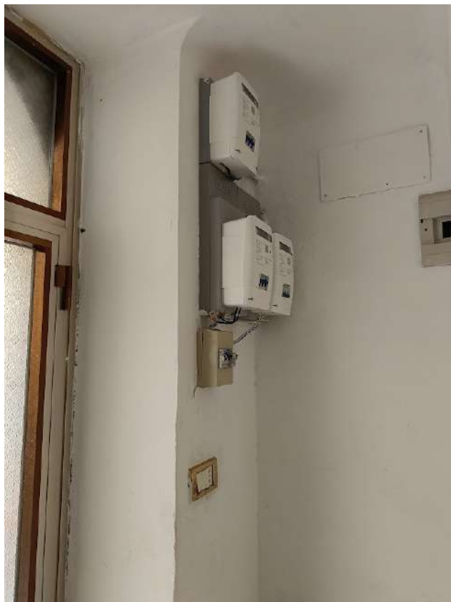
Quadri vano scala
