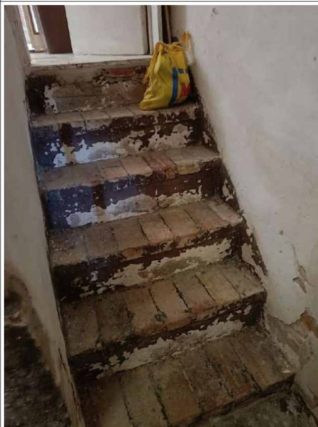
Part scala accesso al 1 livello sottostrada
