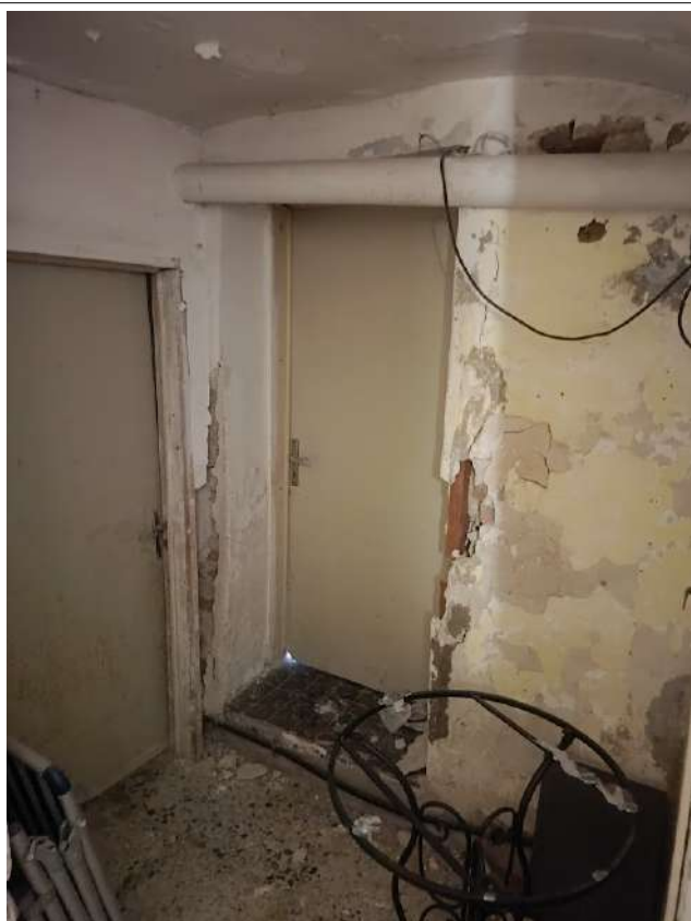
Ingresso locale 1° livello sottostrada
