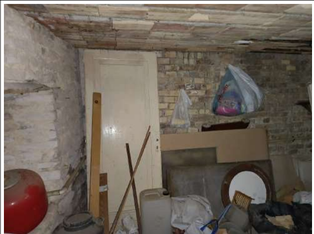
Deposito 2° livello sottostrada
