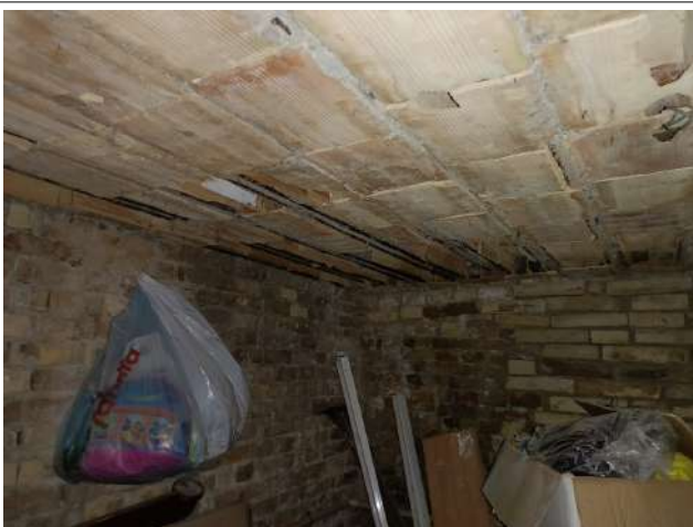
Part. Intradosso solaio
