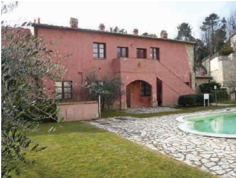
scala di accesso esterna
