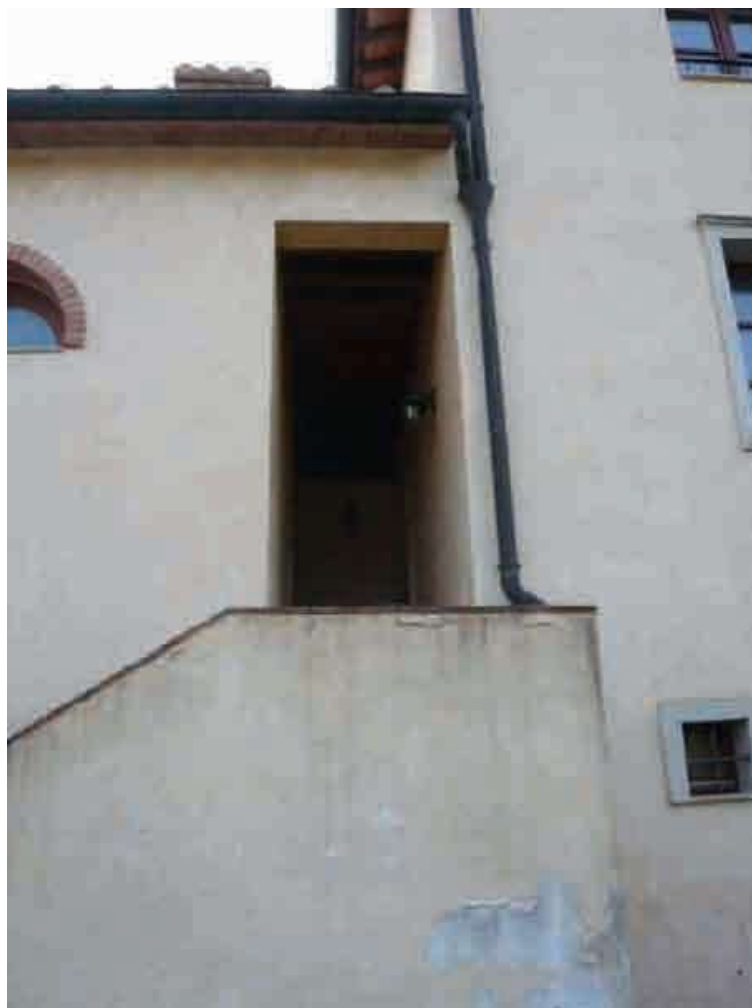
scala condominiale di accesso
