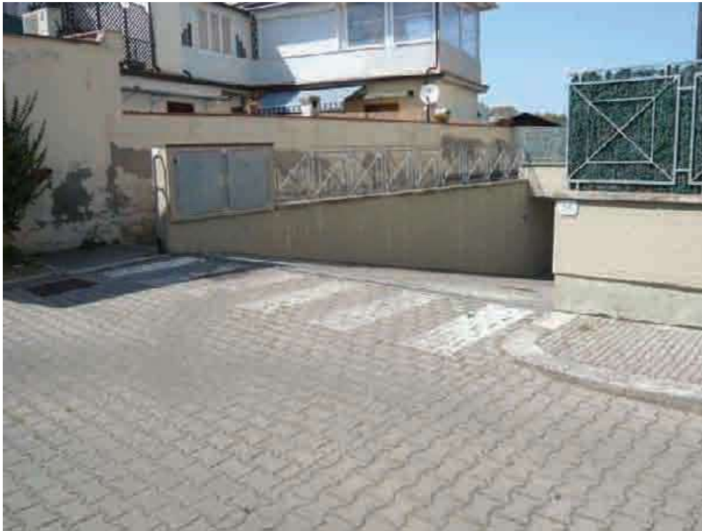
rampa carrabile d'ingresso al parcheggio interrato
