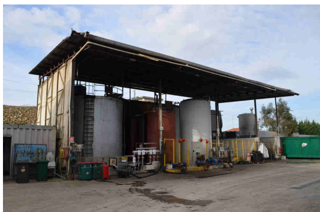
Foto n° 7 – Lotto n° 1 - Capannone a2.
