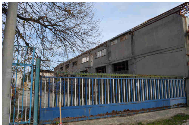
Foto n° 10– Lotto n° 1 -- Capannone a3.
