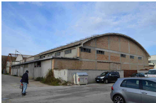
Foto n° 9 – Lotto n° 1 - Capannone a3.
