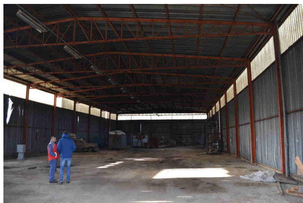
Foto n° 4 – Lotto n° 1 - Capannone a1.
