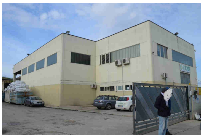
Foto n° 5 – Lotto n° 1 - Capannone a2.
