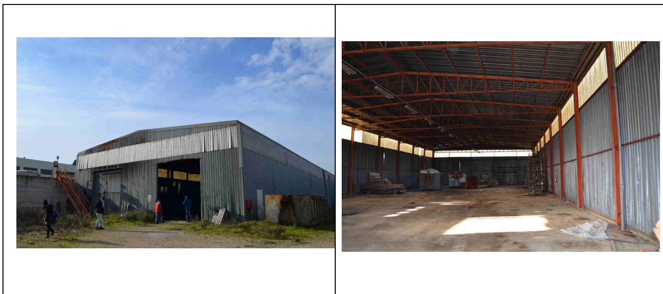
Immagini del capannone - a1 del Lotto n° 1
