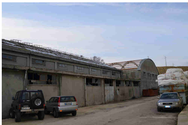
Foto n° 11– Lotto n° 1 -- Capannone a3.
