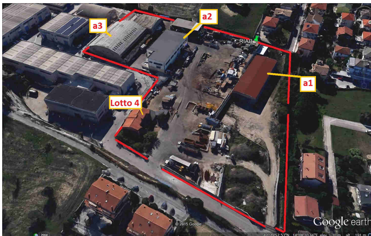
Immagine del complesso produttivo di cui al Lotto n° 1, estratta da Google.
