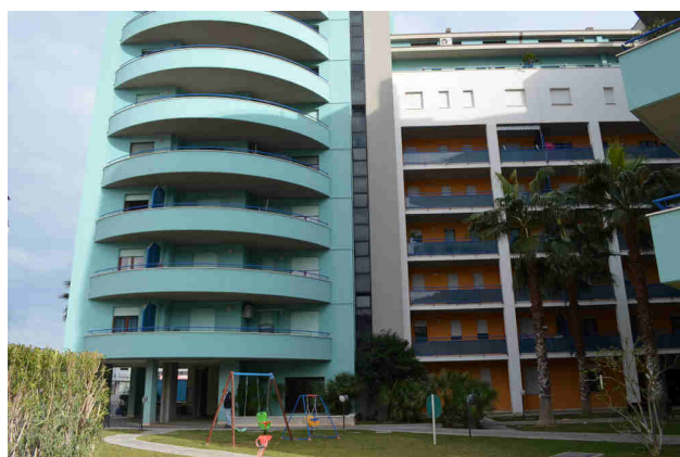
Foto n° 16– Lotto n° 2 – Immobili nell'edificio Condominiale in Montesilvano (PE) Corso Umberto.
