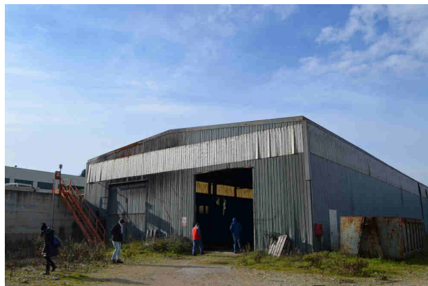
Foto n° 2– Lotto n° 1 – Capannone a1.
