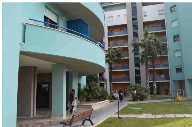
Foto n° 17– Lotto n° 2 – Immobili nell'edificio Condominiale in Montesilvano (PE) Corso Umberto.
