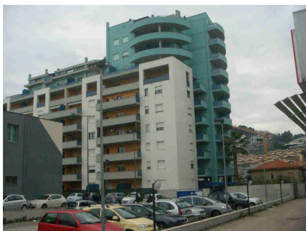
Foto n° 15 – Lotto n° 2 – Immobili nell'edificio Condominiale in Montesilvano (PE) Corso Umberto.
