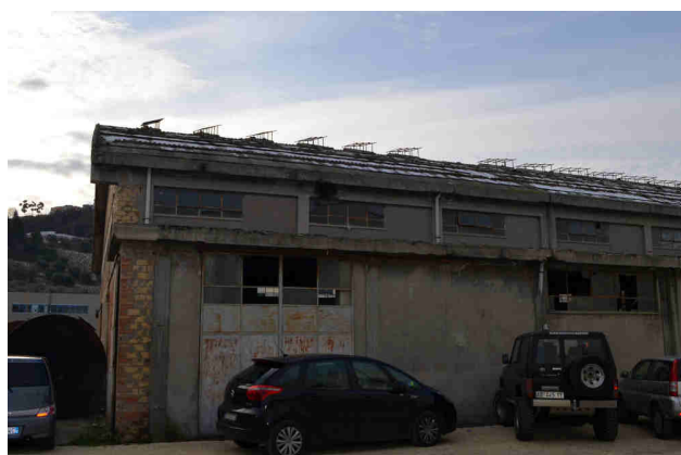
Foto n° 12– Lotto n° 1 -- Capannone a3.
