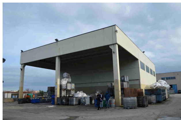
Foto n° 6 – Lotto n° 1 - Capannone a2.
