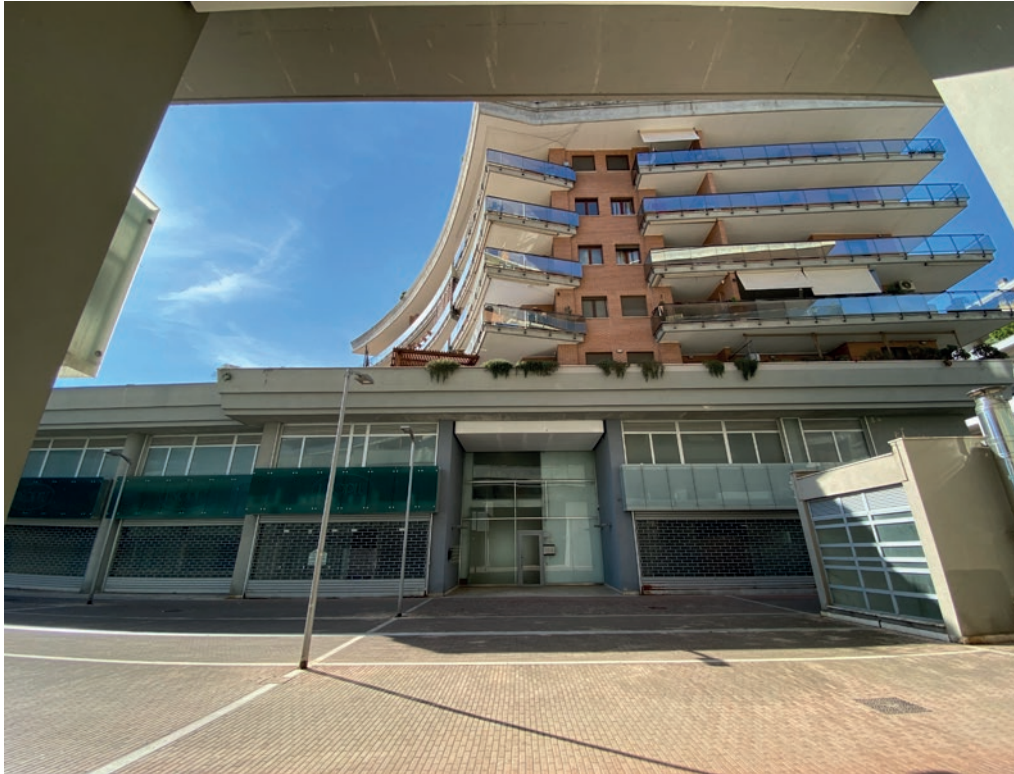
Foto n.1 Veduta esterna edificio
