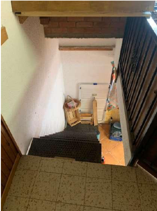
Scala di accesso al piano 1
