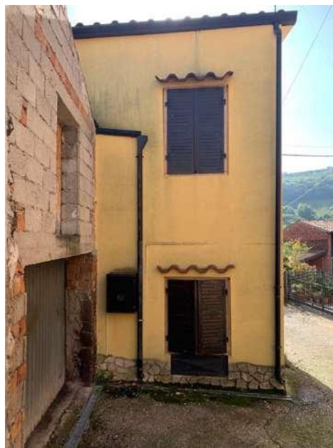
Abitazione – facciata nord
