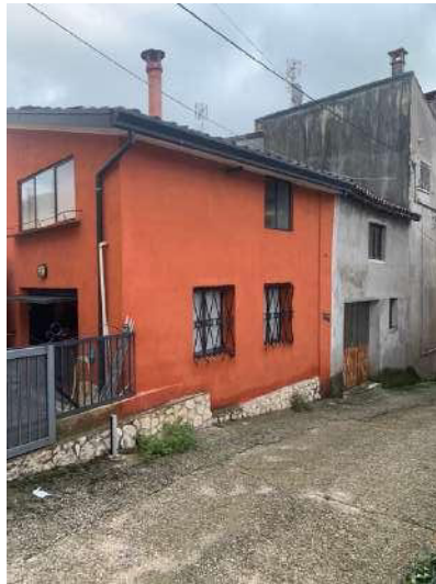
Facciata ovest - garage
