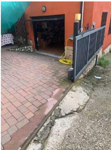
Ingresso al garage
