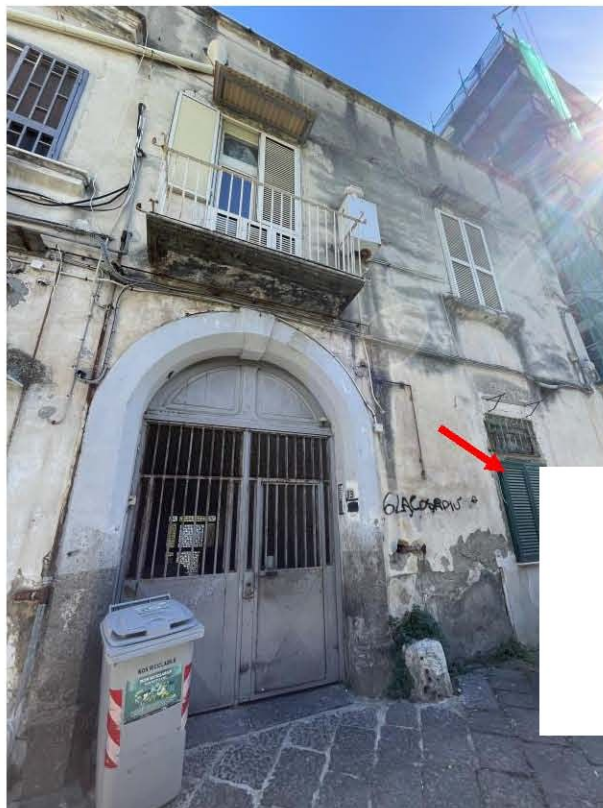
Prospetto del fabbricato su Vico dei Cangì. Si evidenzia l'infisso dell'immobile
