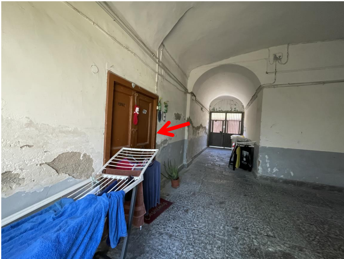
Androne del fabbricato. Si evidenzia la porta d'ingresso all'immobile.
