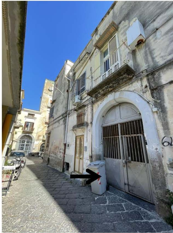
Vico dei Cangì. Si evidenzia il portone di accesso al fabbricato
