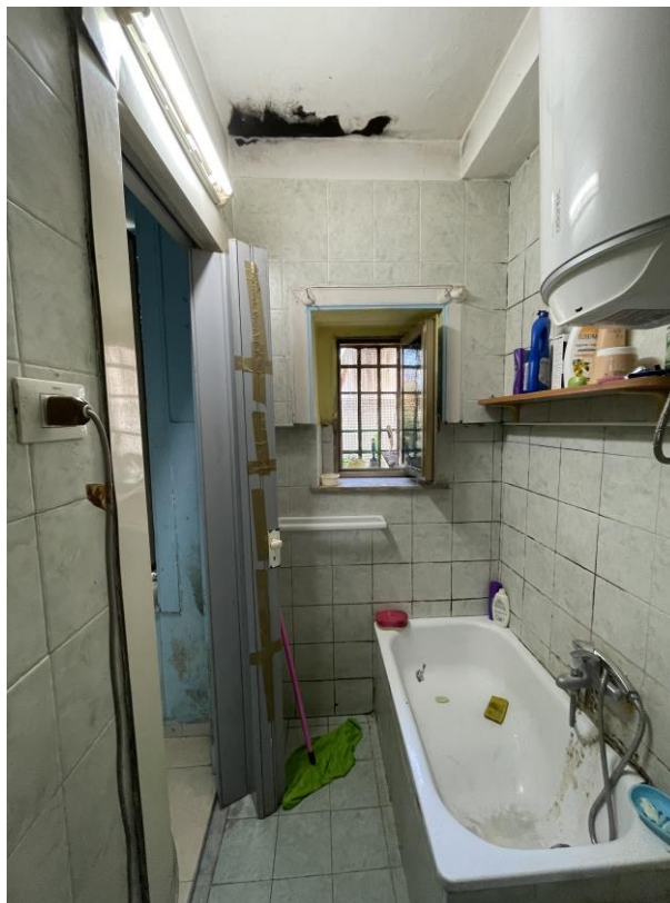
Bagno. Veduta verso la finestra
