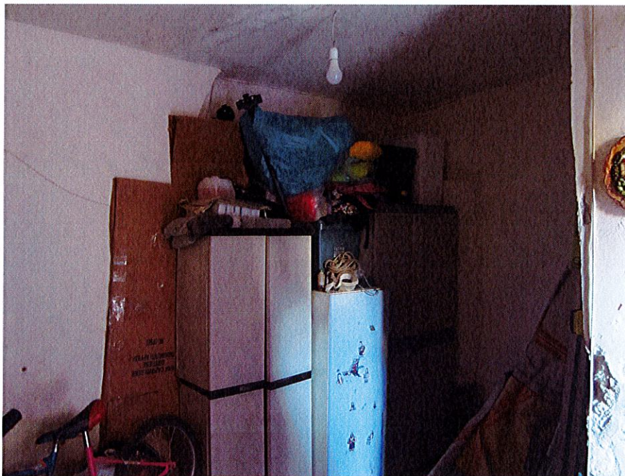
5 – particolare, dal vano con accesso dal cortile interno, delle masserizie appoggiate alla parete divisoria cui è stato giustapposto pannello di compensato.
