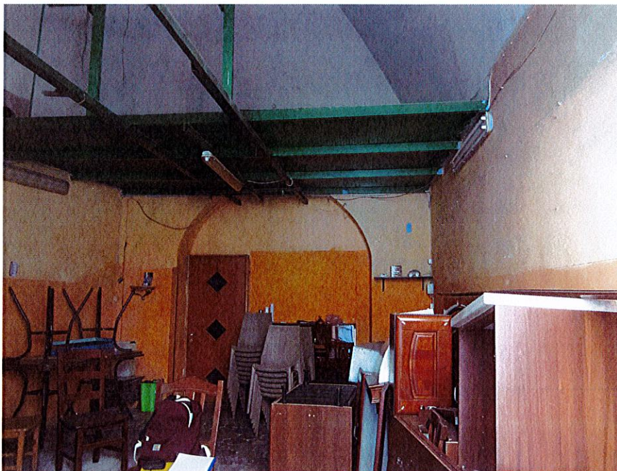
1 – vista dell'interno del vano prospiciente la strada; sulla parete di fondo la porta del bagno che è stata spostata ed alla destra di questa il pannello di compensato a chiusura del passaggio esistente.
