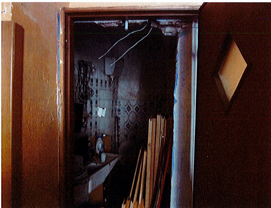
4 – particolare della nuova apertura di accesso al bagno; quella preesistente si trovava dove ora risultano appoggiati quei pannelli in legno.
