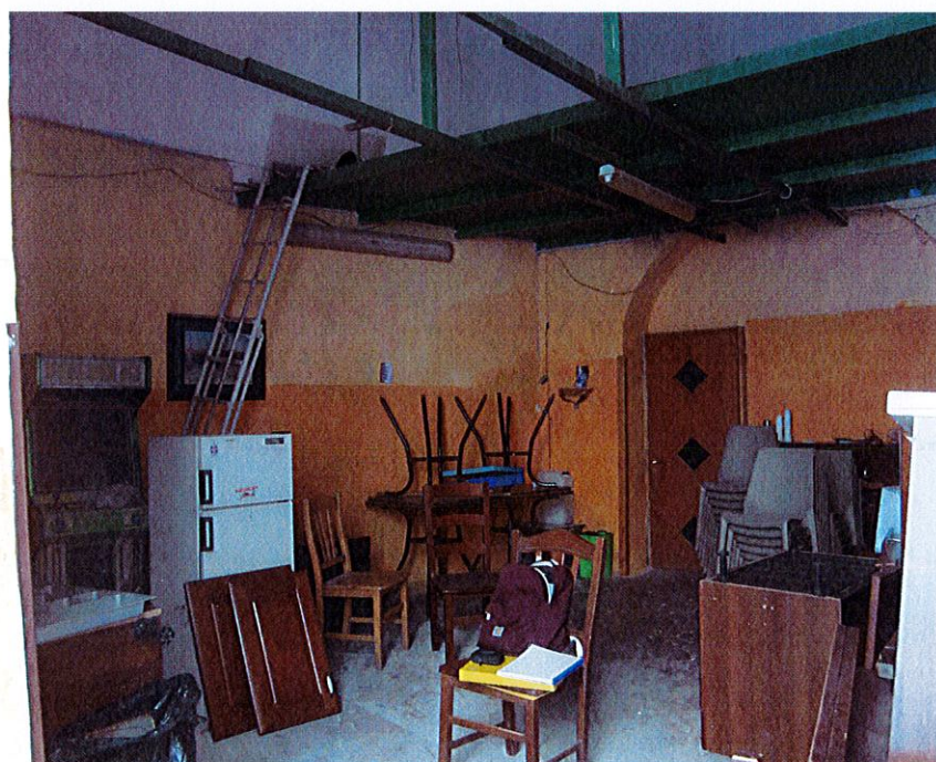
2 – vista della zona immediatamente prossima all'accesso dalla strada; si può notare che confrontando lo stato attuale con le foto che risalgono a circa dieci anni fa nulla è cambiato: la scala ed il soppalco allora esistenti sono gli stessi che notiamo al giorno d'oggi.
