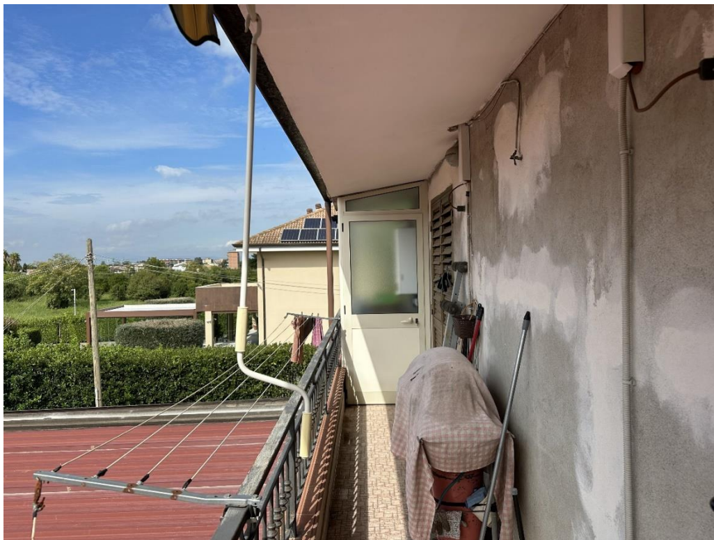
FOTO: VANO RIPOSTIGLIO POSTO SUL BALCONE N°2
