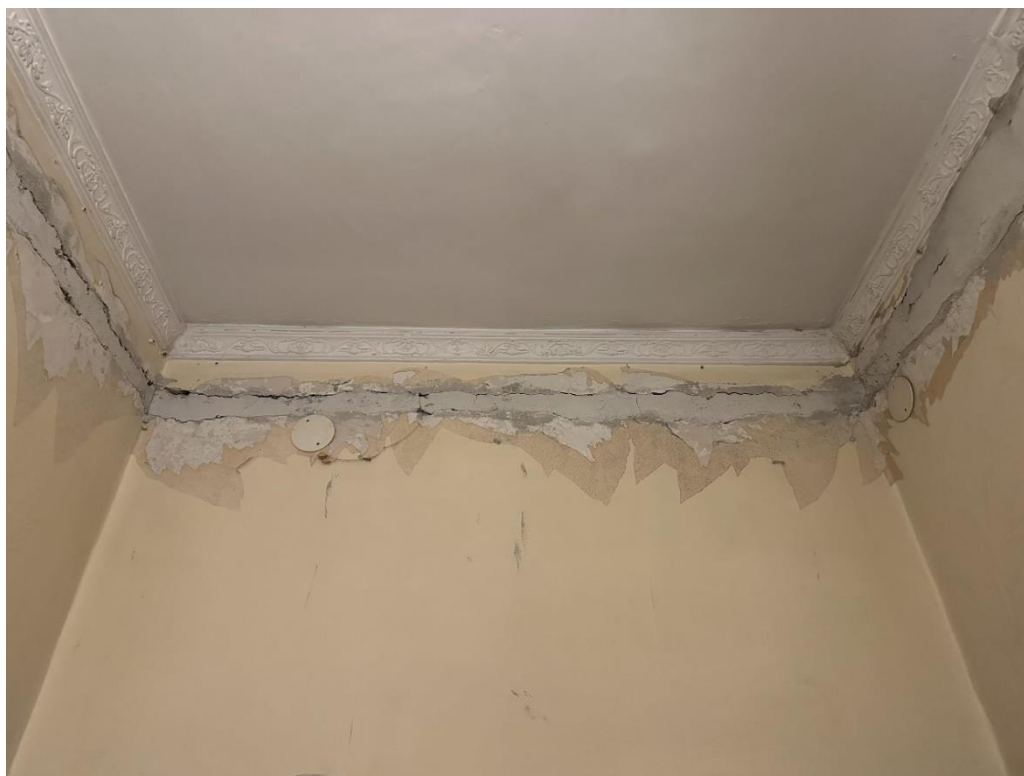
FOTO: PARTICOLARE DELLE TRACCE ESEGUITE SULLA PARETE DEL VANO DISIMPEGNO
