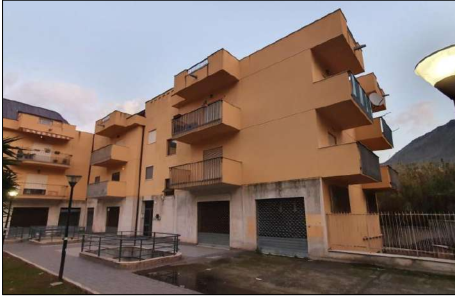
Foto 1– Prospetto del fabbricato
