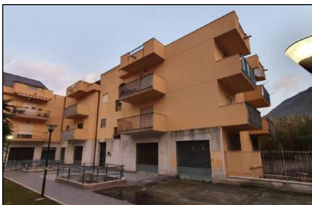
Foto 1– Prospetto principale del fabbricato
