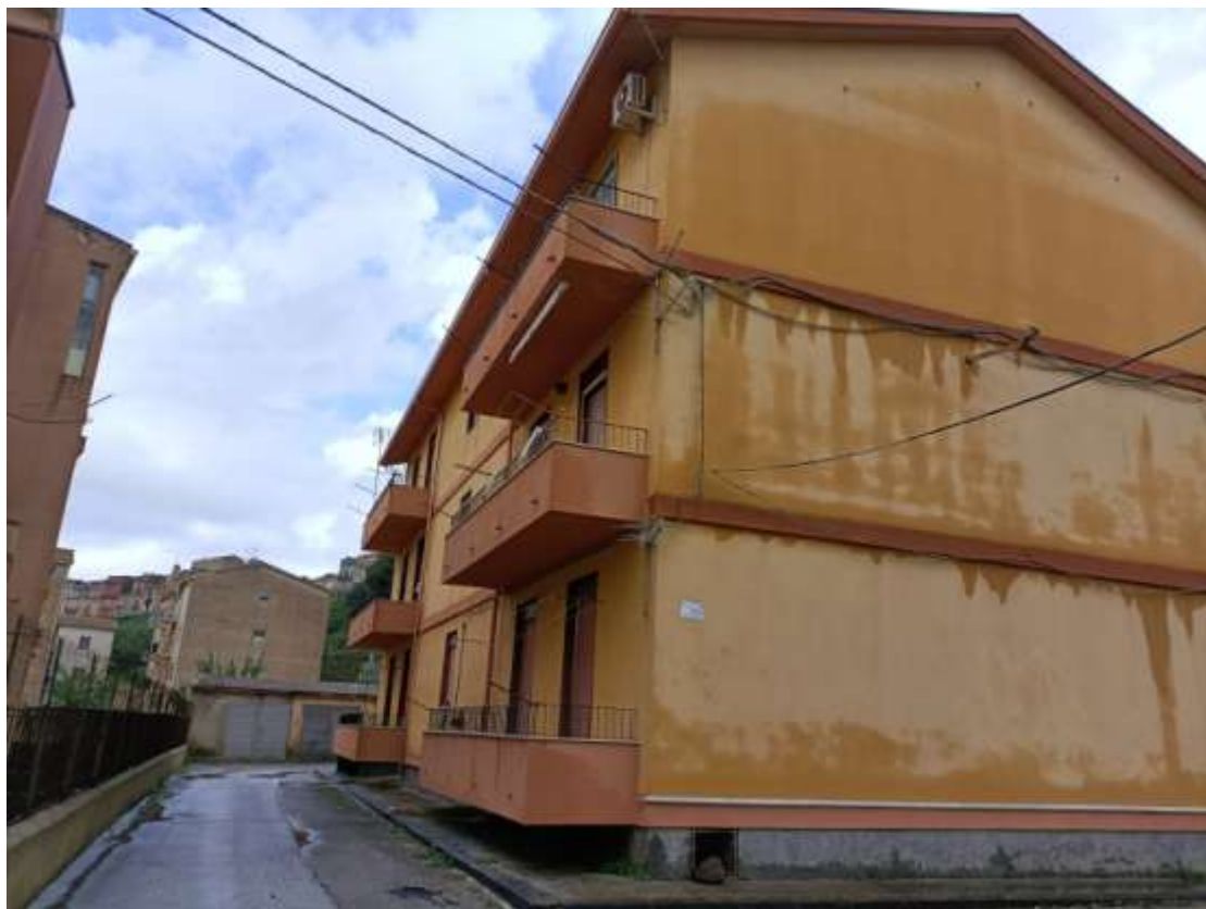
Foto n° 1 Vista sud palazzina A,
