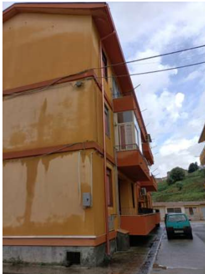
Foto n° 2 vista nord palazzina A e veranda
