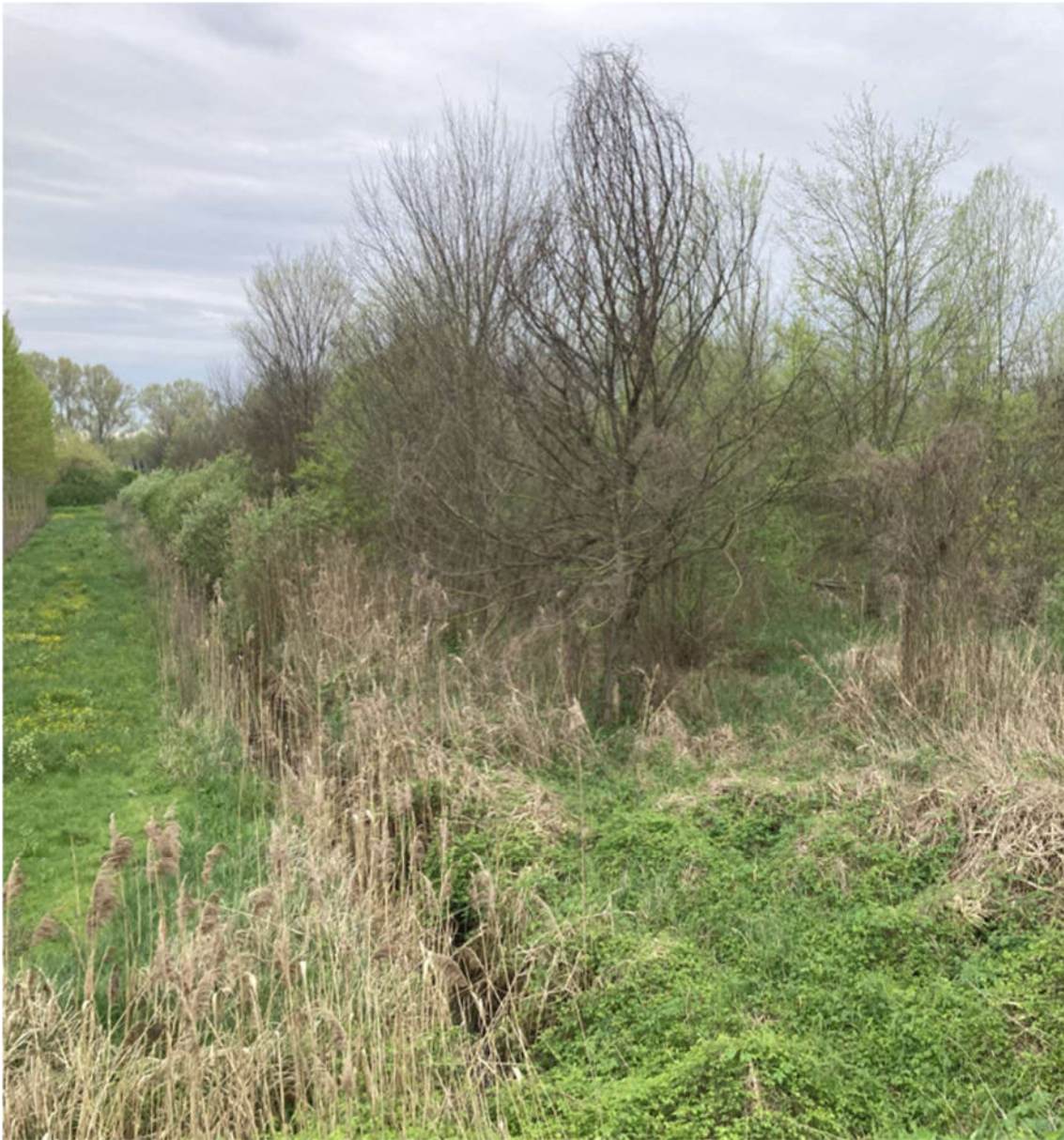
Scolina laterale lotto 2 – confine sud-ovest con pioppeto
