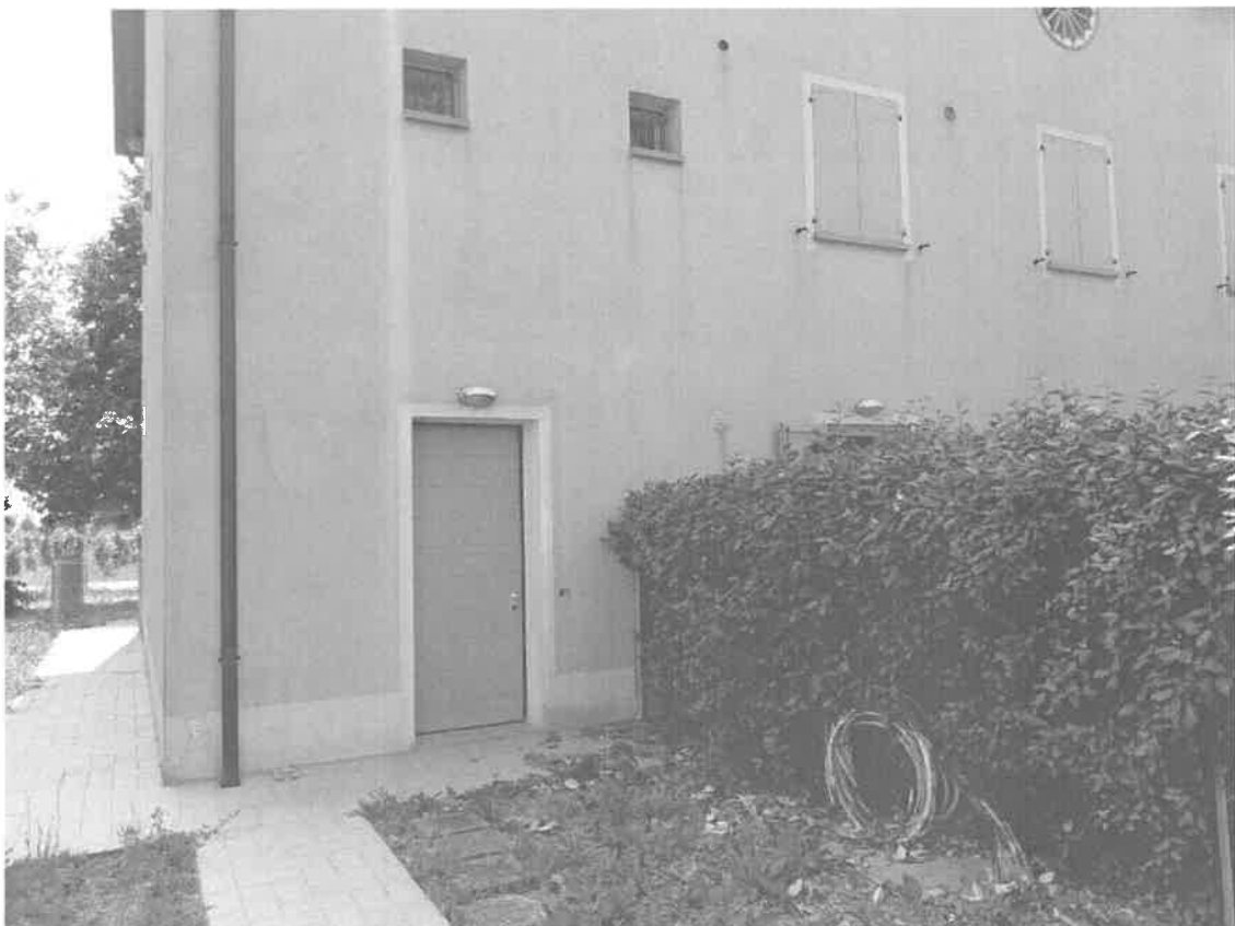
Lotto "1/04" / F3 - Portone di accesso ad una delle due abitazioni in corso di costruzione
