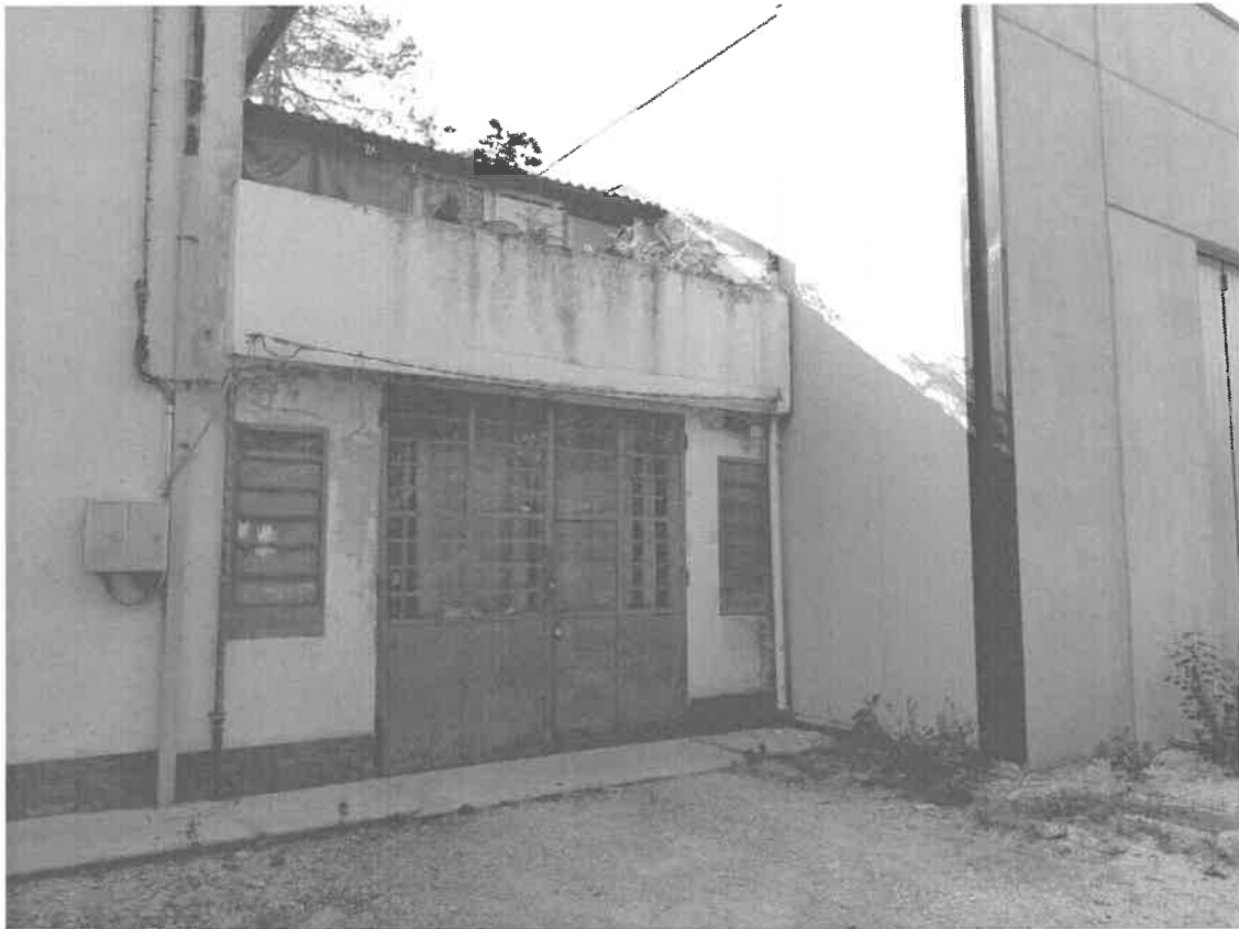
Lotto "1/06" / F2 - Deposito Sub. 11 fra la porzione abitativa (a sinistra) e il nuovo capannone
