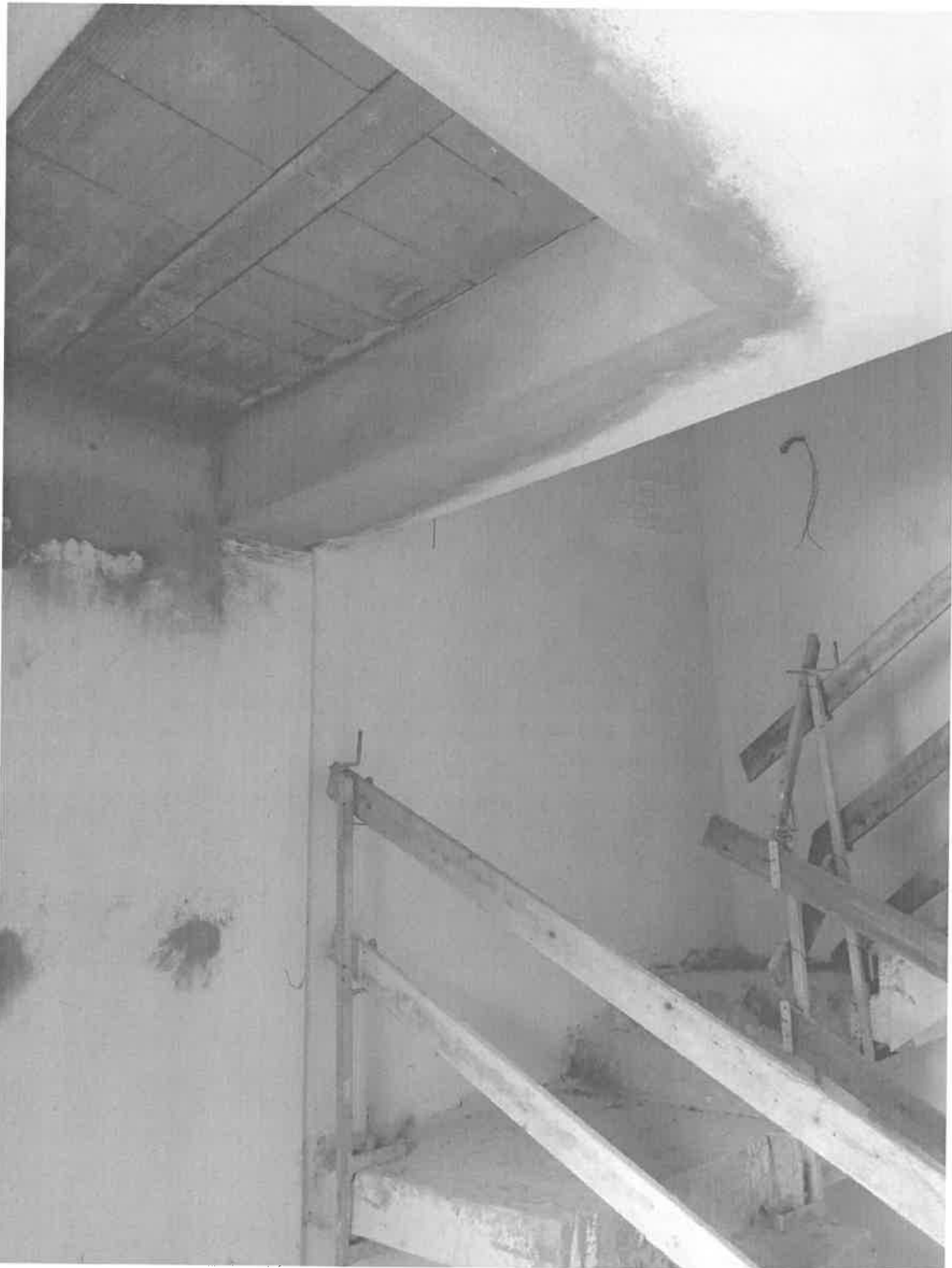
Lotto "1/04" / F8 - Vano scala interno con predisposizione per installazione di elevatore
