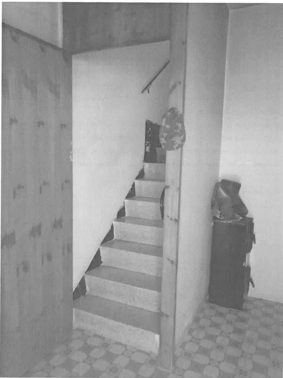
Lotto "1/05" / F5 - La scala interna per l'accesso al primo piano
