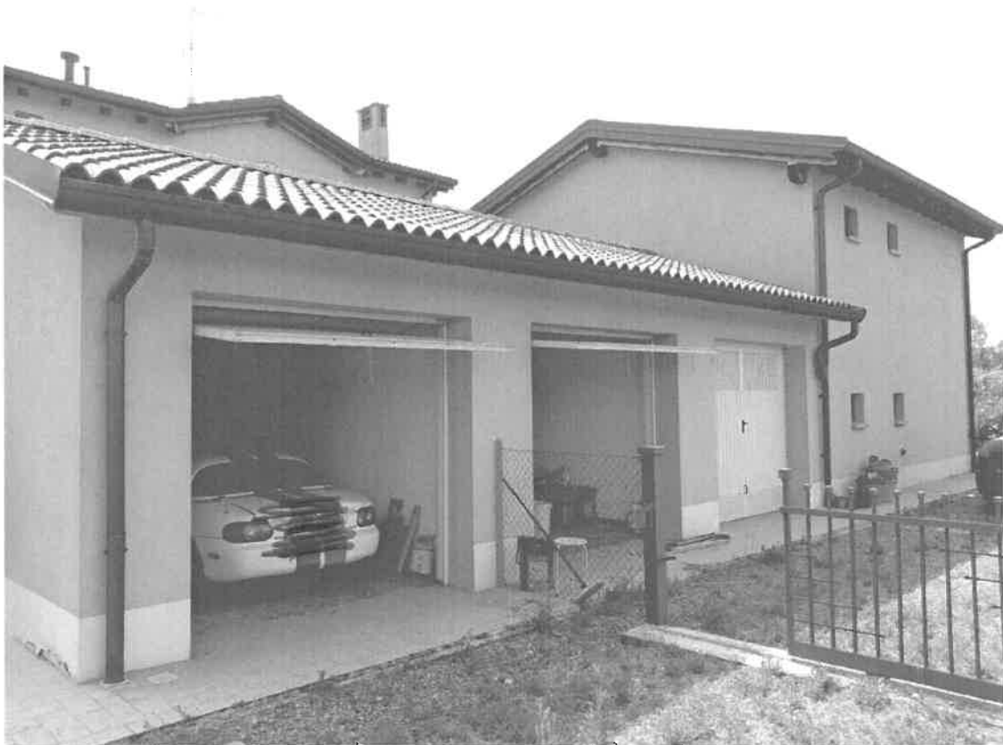
Lotto "1/04" / F9 - Vista di insieme delle due autorimesse Sub. 11 (aperte) di pertinenza degli alloggi in corso di costruzione
