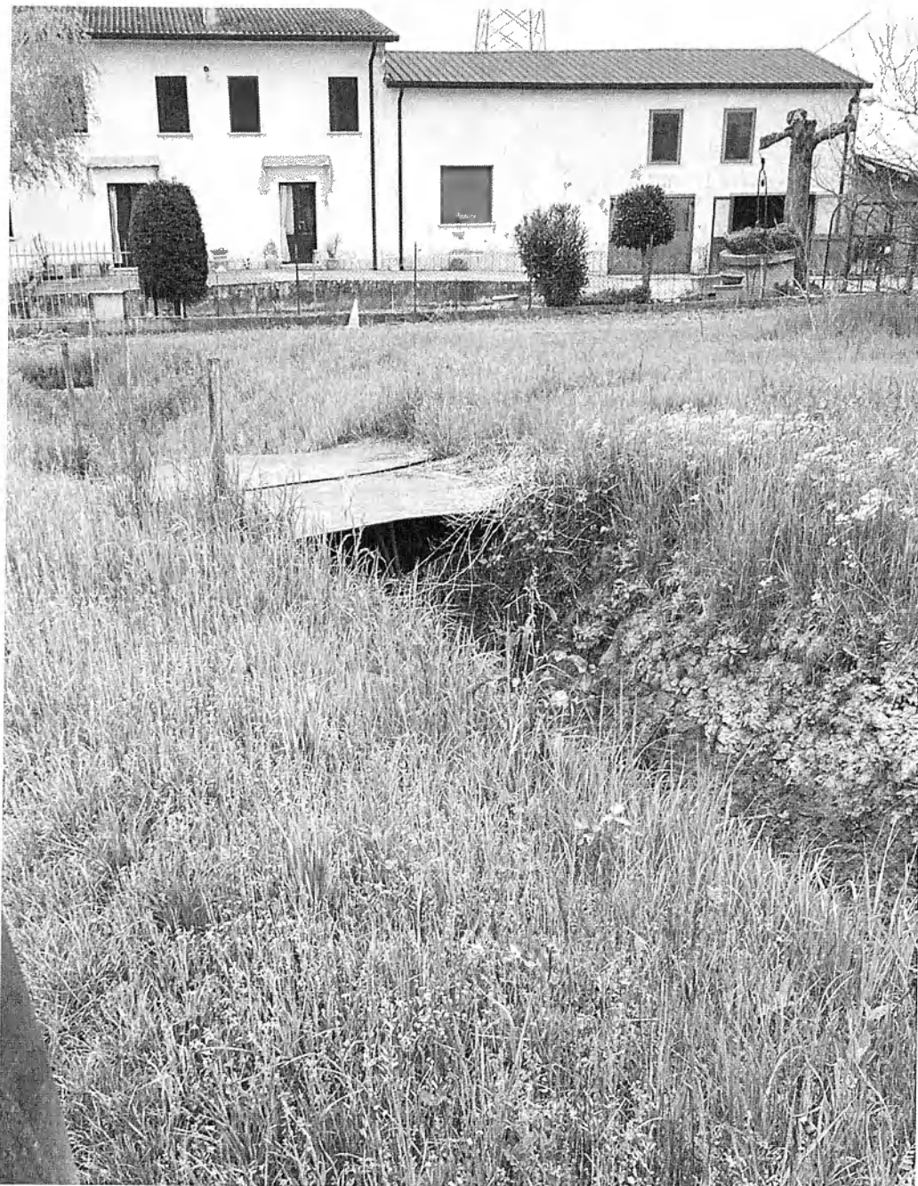
Zona fronte strada mappale 237 (via Barbugine) – Edificio di terzi confinante al lotto pignorato
