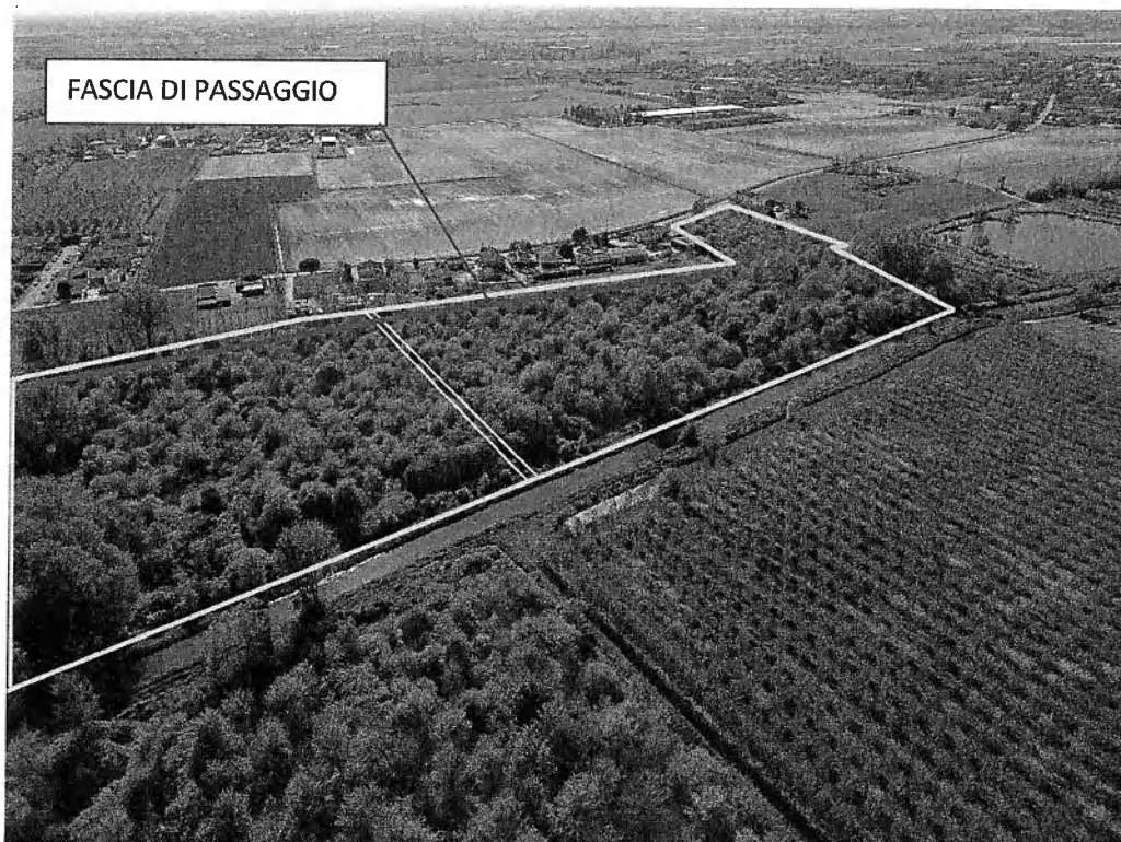
Vista aerea Lotto 1
