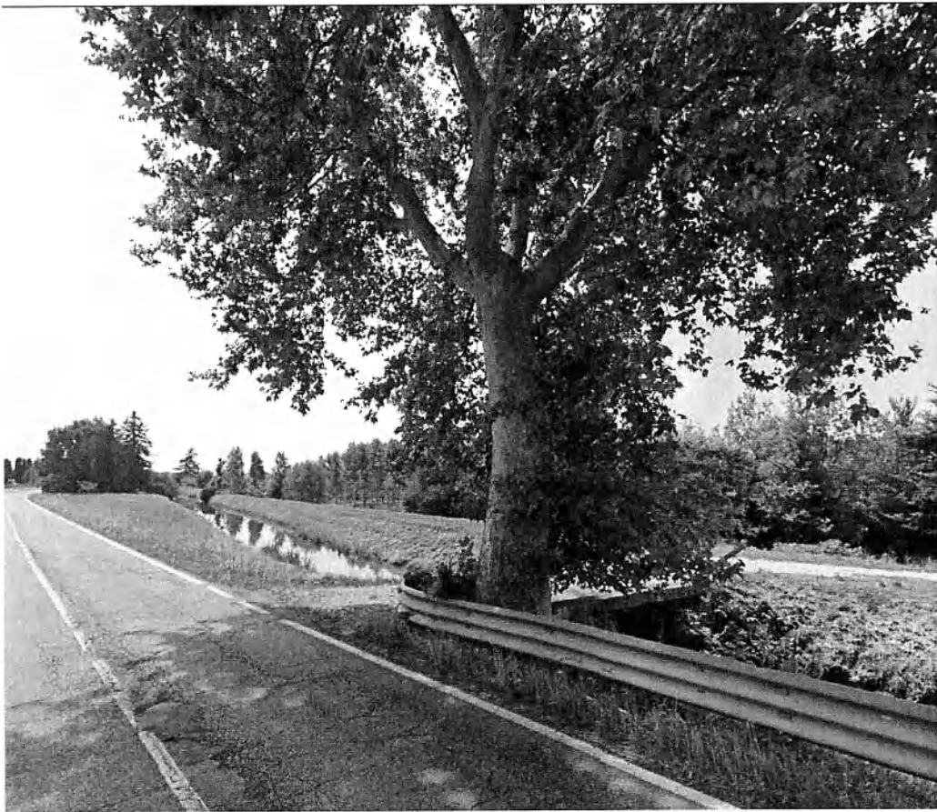
Ingresso da Via San Zeno
