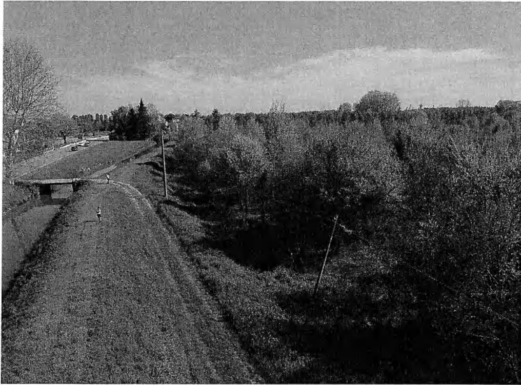
Vista aerea Lotto 2 – lato Nord Ovest
