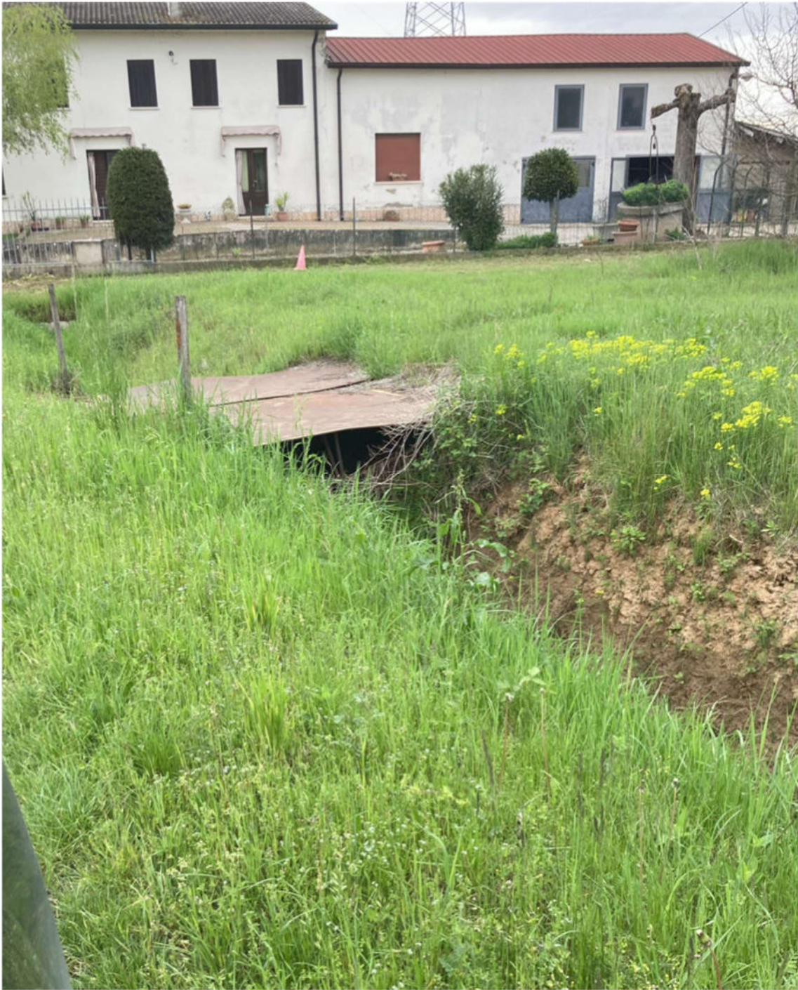
Zona fronte strada mappale 237 (via Barbugine)
