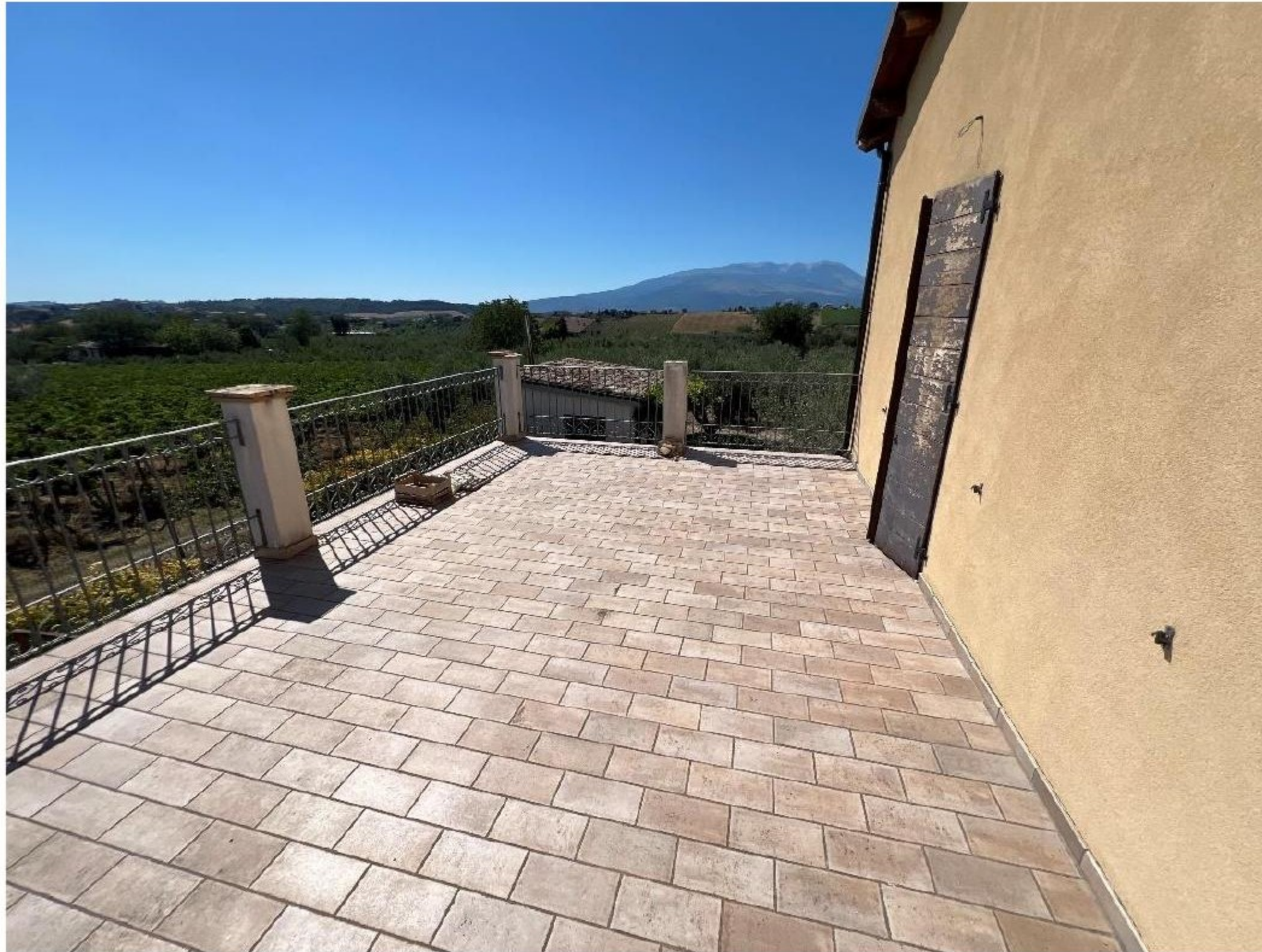
Terrazzo piano primo esposizione lato est
