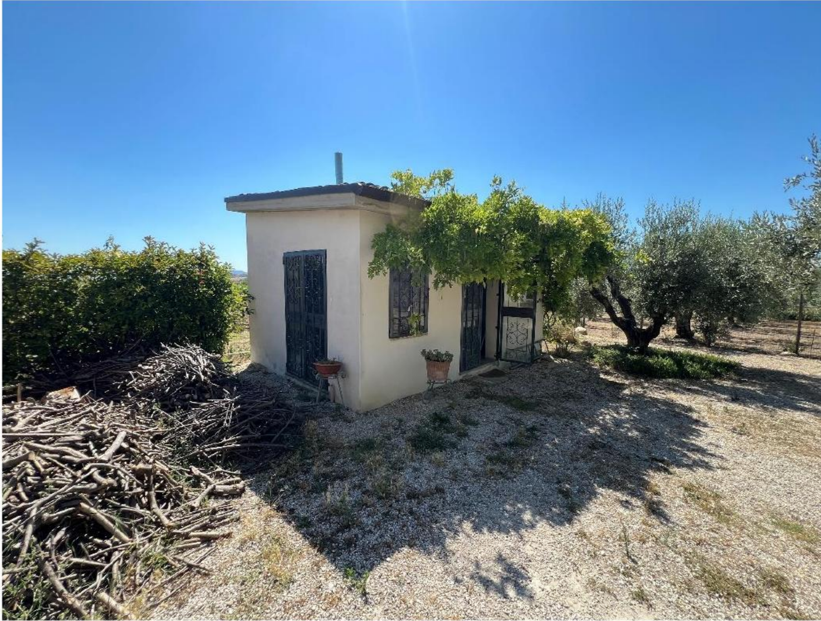
Vista esterna del fabbricato della centrale termica
