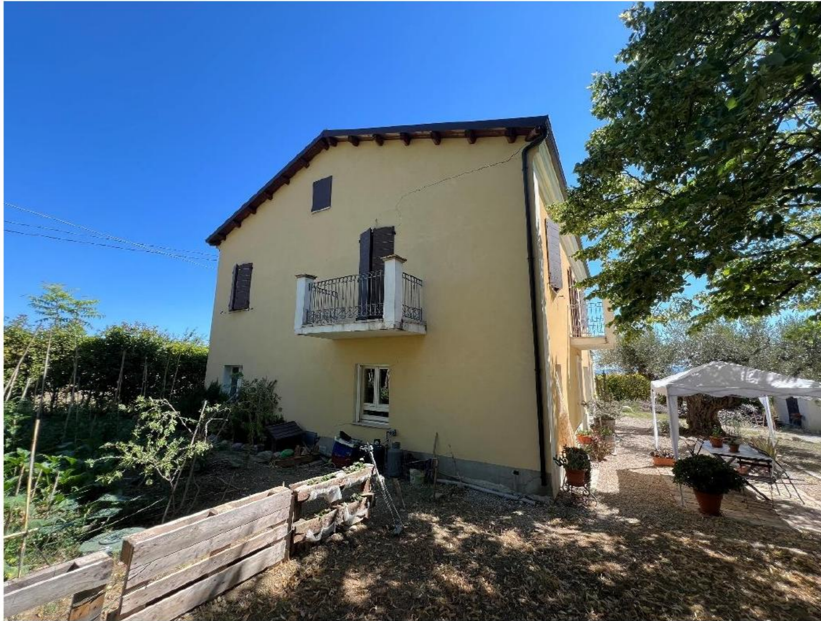
Vista esterna del fabbricato lato sud-ovest
