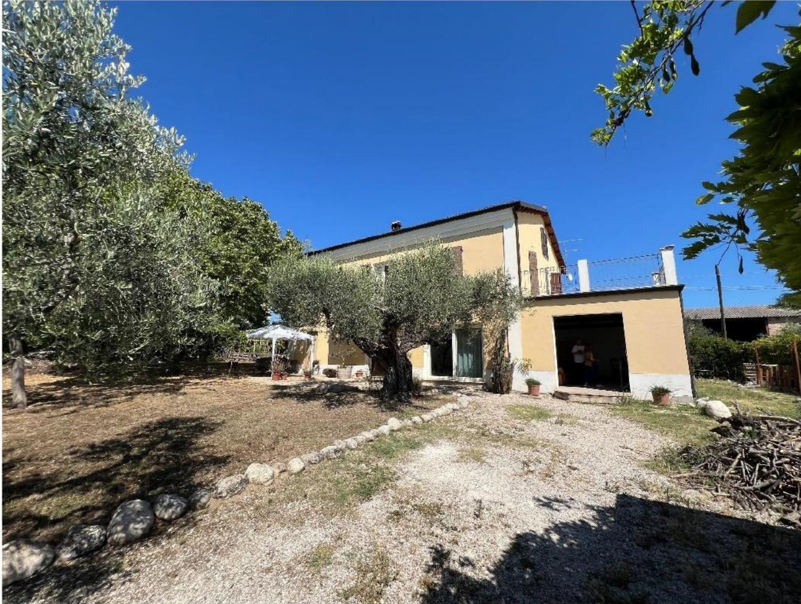
Vista esterna del fabbricato lato sud
