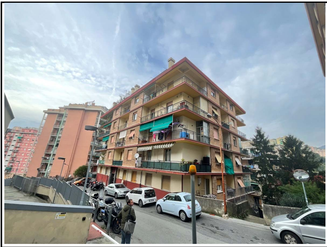
Foto 1 – Particolare edificio Via Edera civ. 18
