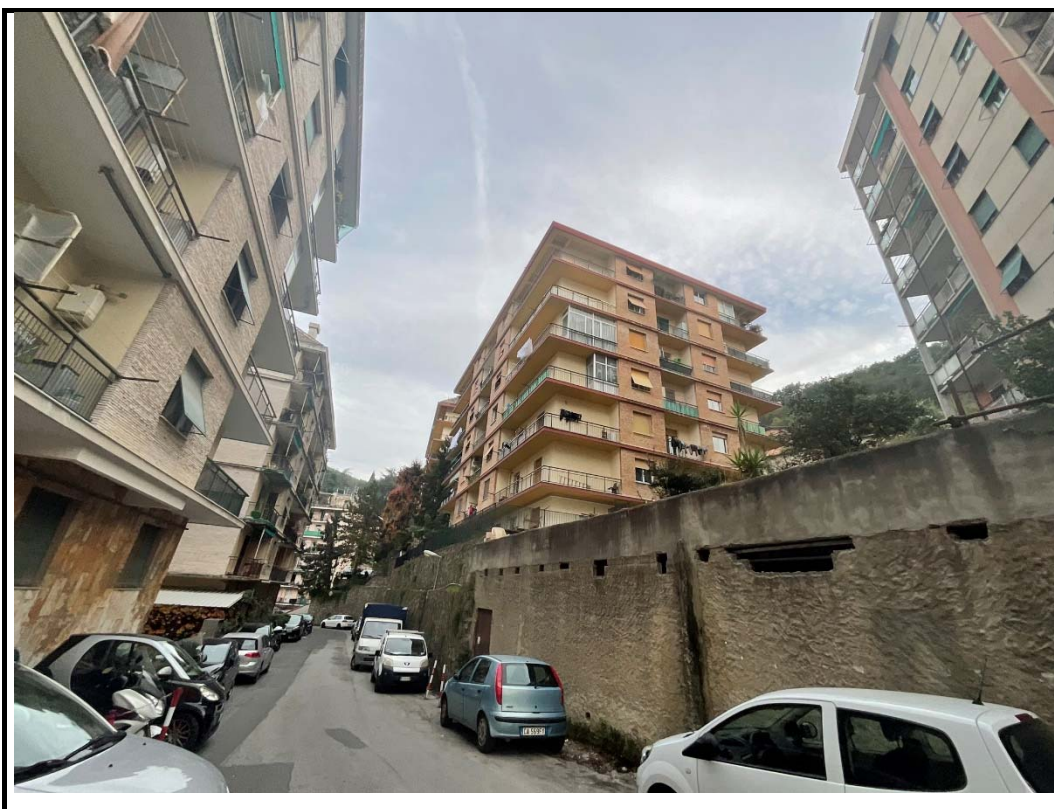
Foto 2 – particolare fabbricato visto da dietro
