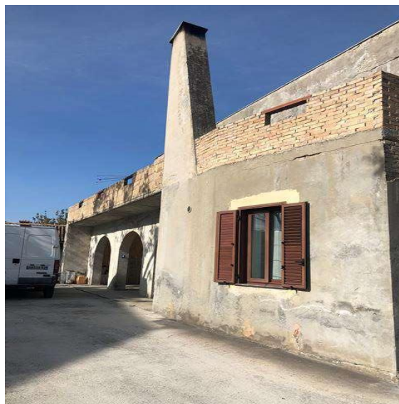
Foto n° 4-Bene n° 1 e 3 veduta esterna lato ingresso
