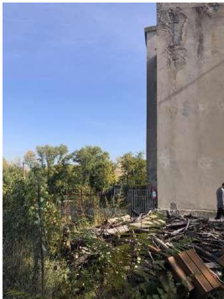
Foto n° 5–Lotto 1 -Bene n°1 e 3 veduta esterna lato posteriore
