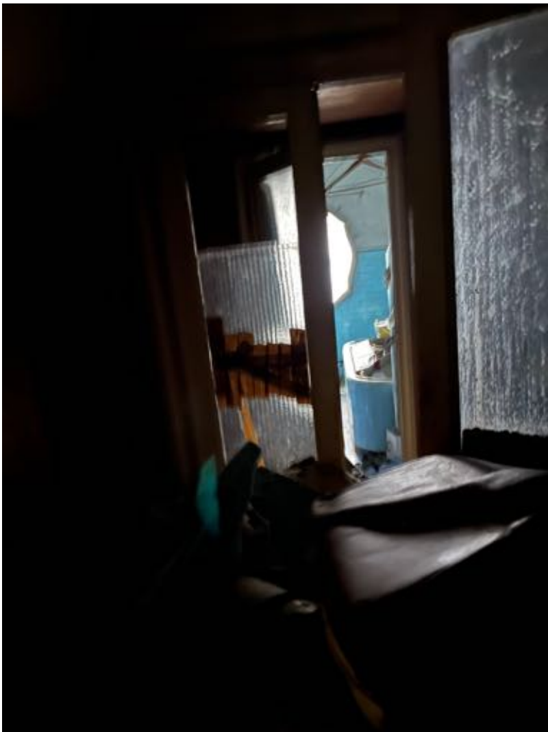
Vista del bagno al p. primo.
