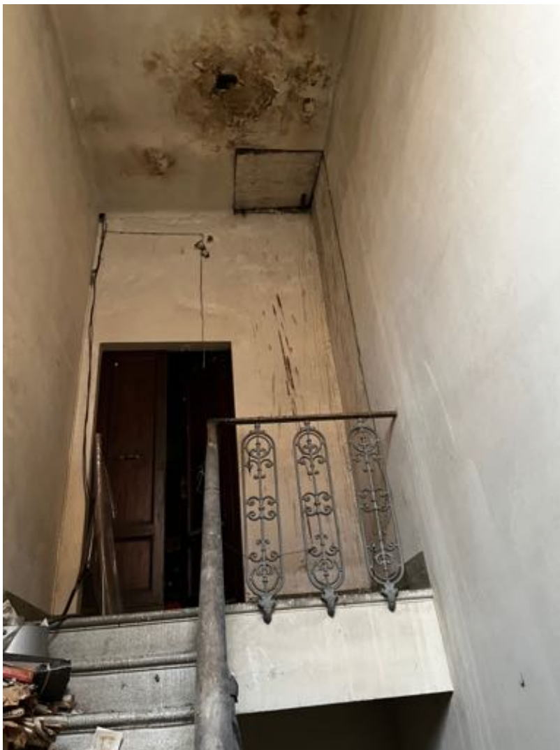
Vista del vano scale verso il p. primo.
