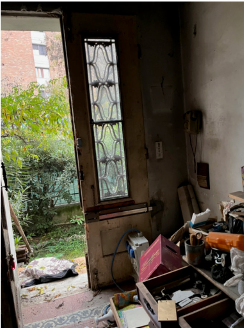
Vista dell' atrio d' ingresso al p. terra.
