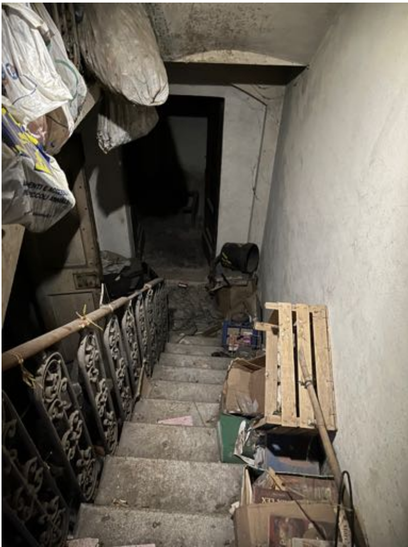
Vista della scala verso il p. seminterrato.
