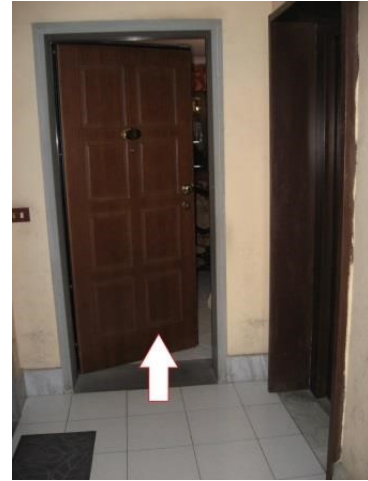
Figura 9 accesso all'appartamento interno n.5 dal vano scala con ascensore
