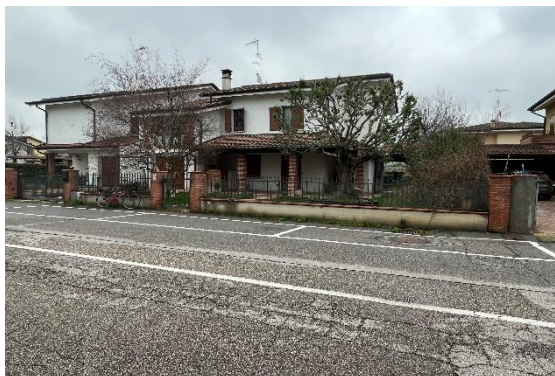
1 Vista da via Fellini
