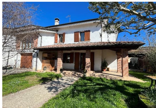
2 Vista fronte Ovest
