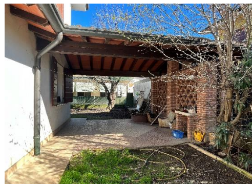
16 Portico a lato Sud
