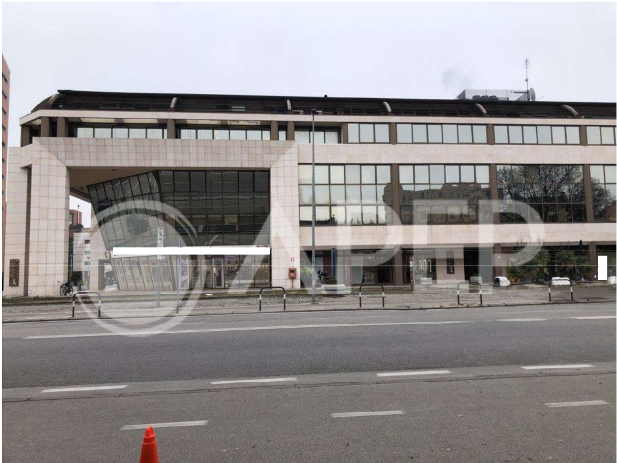
foto n. 1 – facciata su via Tommaseo
