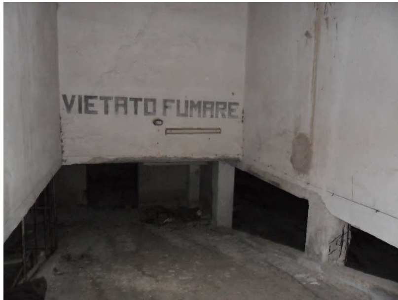
Immagine n.3: foto rampa di accesso all'autorimessa dal civico 1
