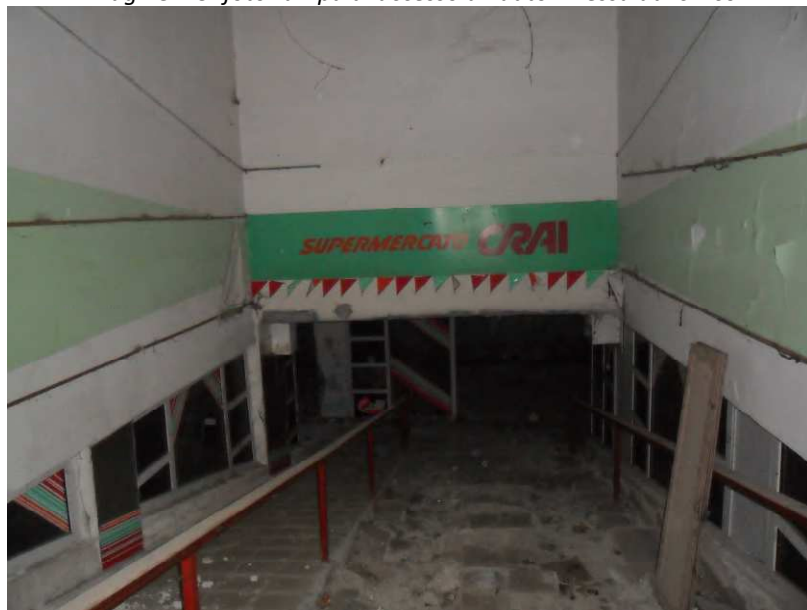
Immagine n.4: foto rampa di accesso all'autorimessa dal civico 9
