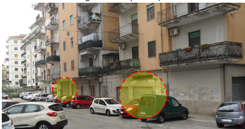
Immagine n.2: foto di ingresso all'autorimessa in Eboli di via Giovanni Paolo I civici 1 e 9
