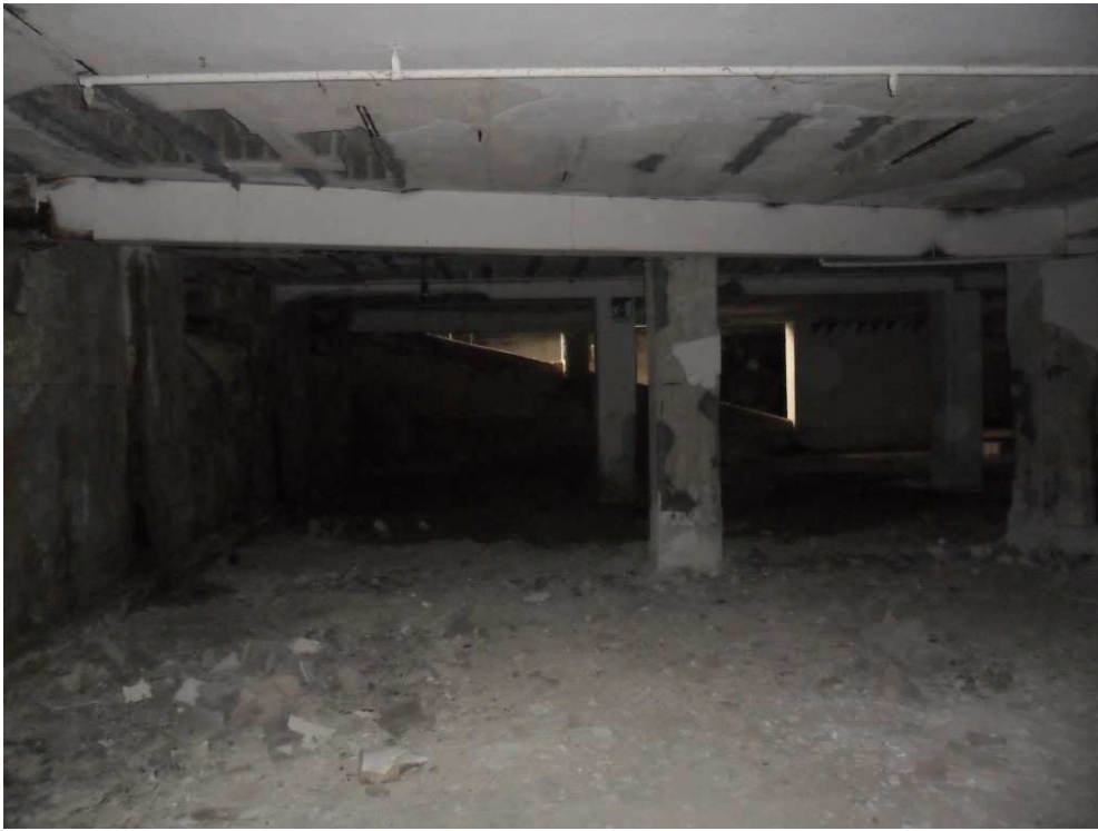
Foto n.8: laterale dei corridoi trasversali dell'autorimessa
