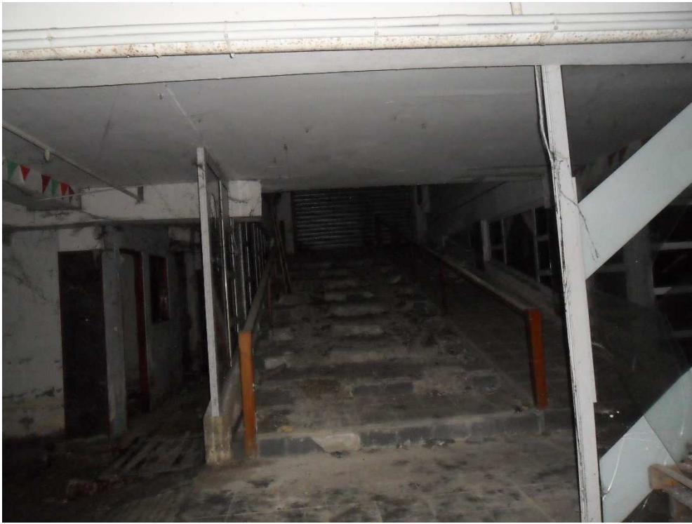
Foto n.4: seconda rampa di accesso all'autorimessa interrata da via Giovanni Paolo I dal civ. 9
