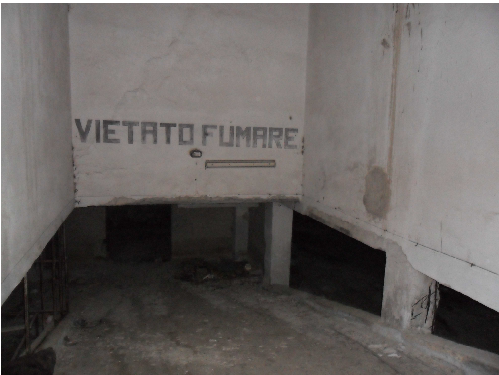
Foto n.3: prima rampa di accesso all'autorimessa interrata da via Giovanni Paolo I dal civ. 1
