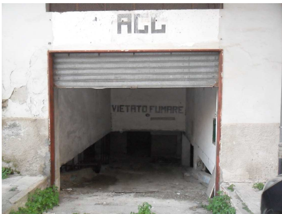
Foto n.1: porta di accesso all'autorimessa interrata da via Giovanni Paolo I al civ. 1
