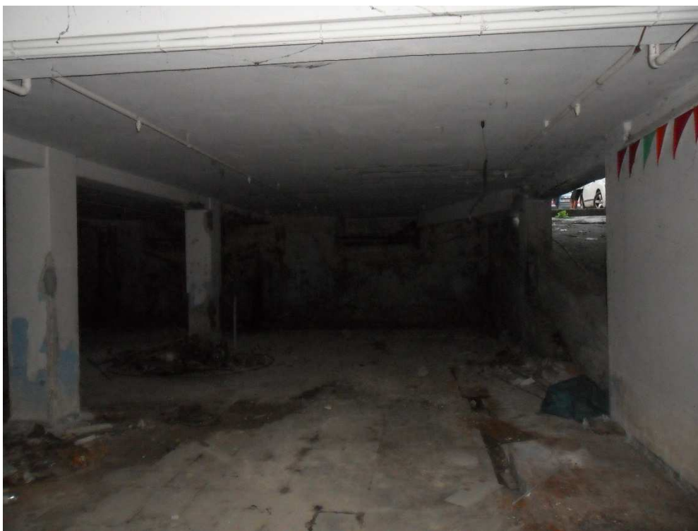
Foto n.6: corridoio trasversale della autorimessa
