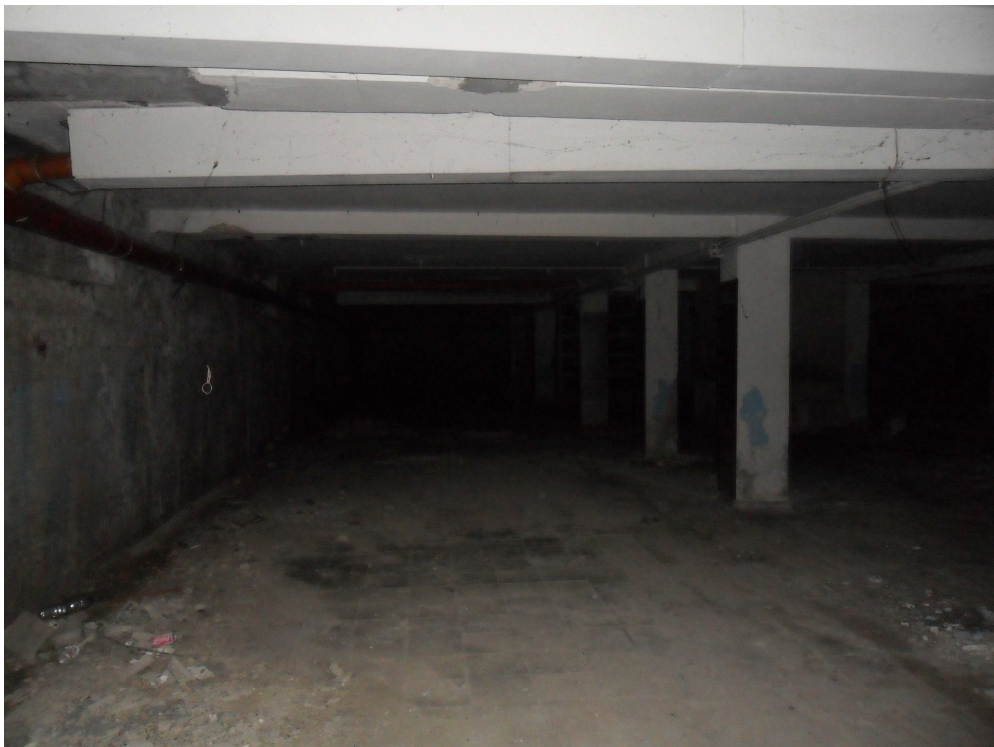
Foto n.5: corridoio principale della autorimessa
