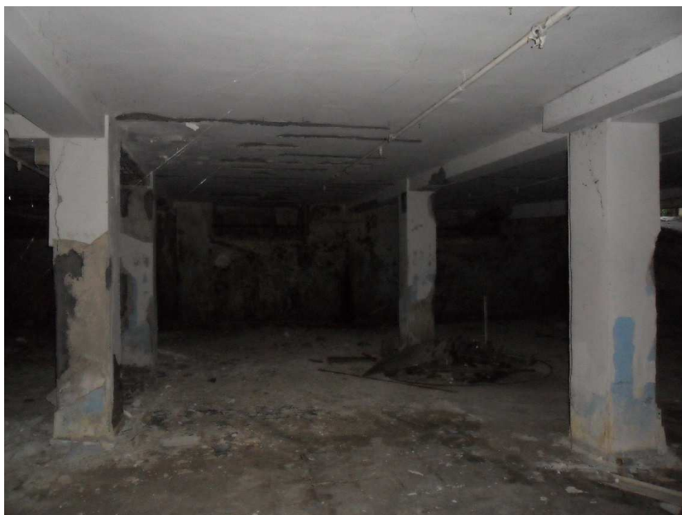
Foto n.7: corridoio trasversale della autorimessa
