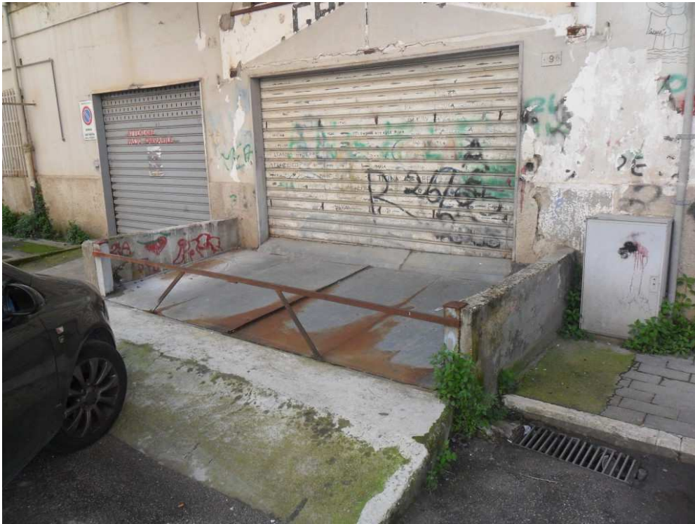
Foto n.2: porta di accesso all'autorimessa interrata da via Giovanni Paolo I al civ. 9
