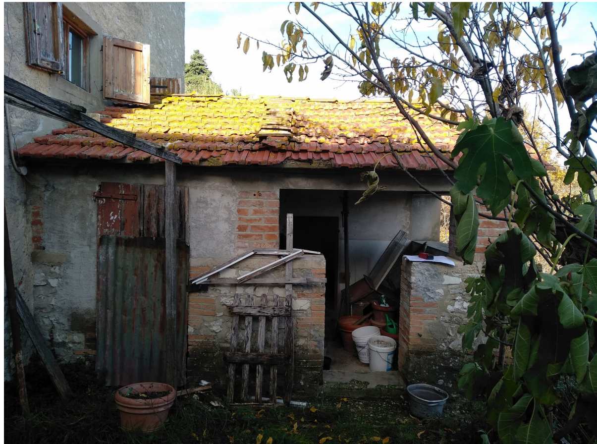
Foto 2 – veduta interna dell'immobile
