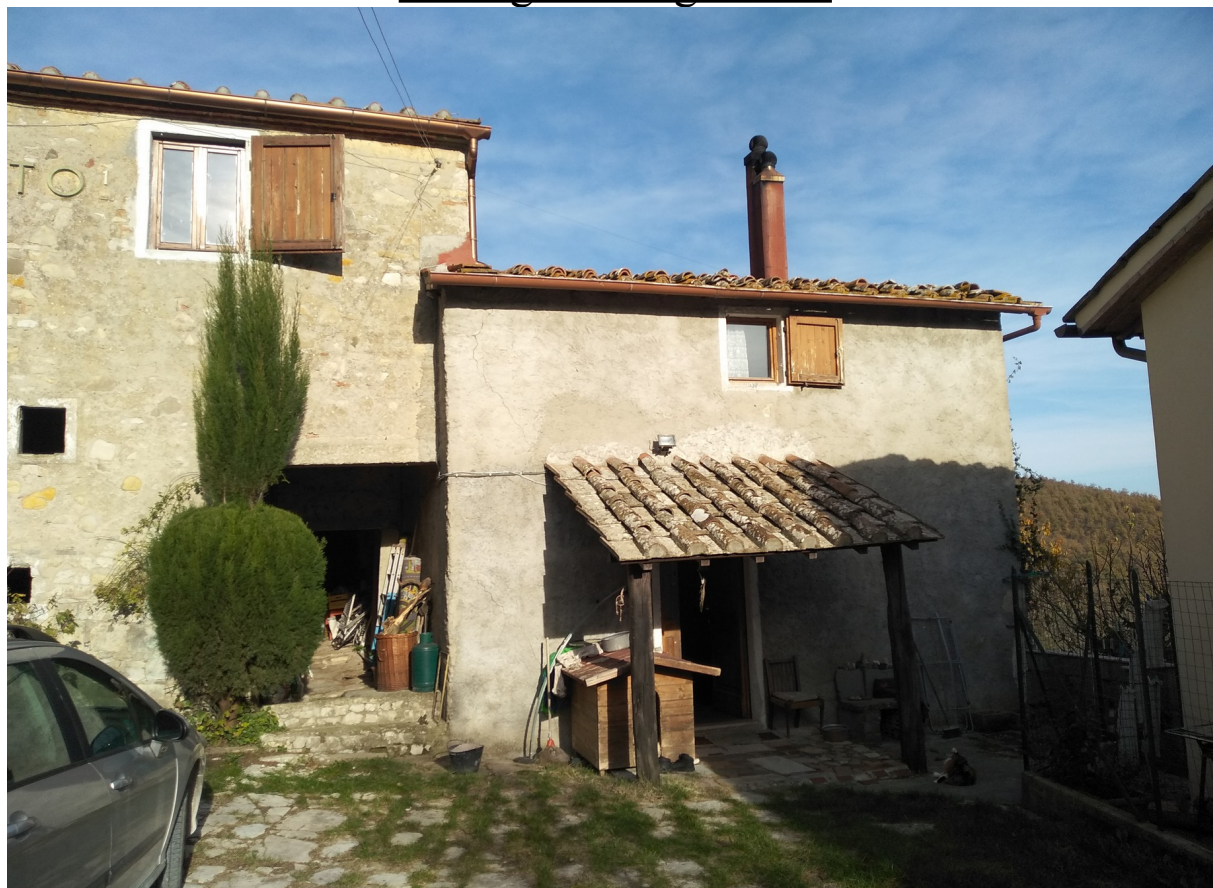
Foto 1 – veduta esterna dell'immobile
