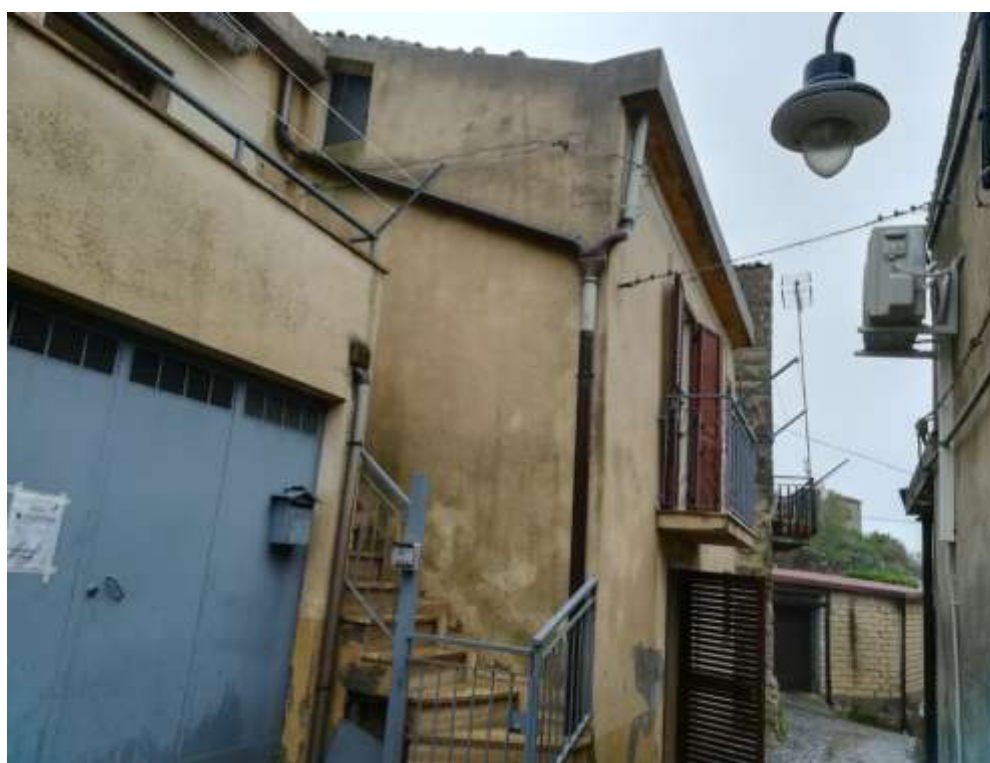
Foto n. 4- Ingresso garage e scala di accesso esterna
