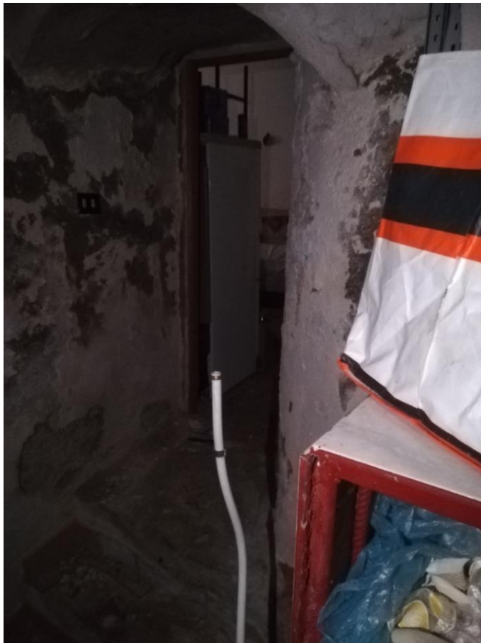
Foto 12 – Ripostiglio annesso al Garage
