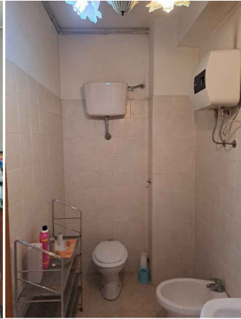
Bagno al piano interrato
