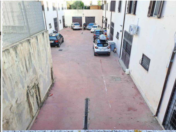
Affaccio dal terrazzo 1 verso l'area condominiale di parcheggio
