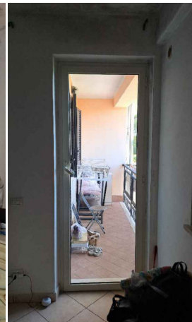
Accesso alla loggia 3
