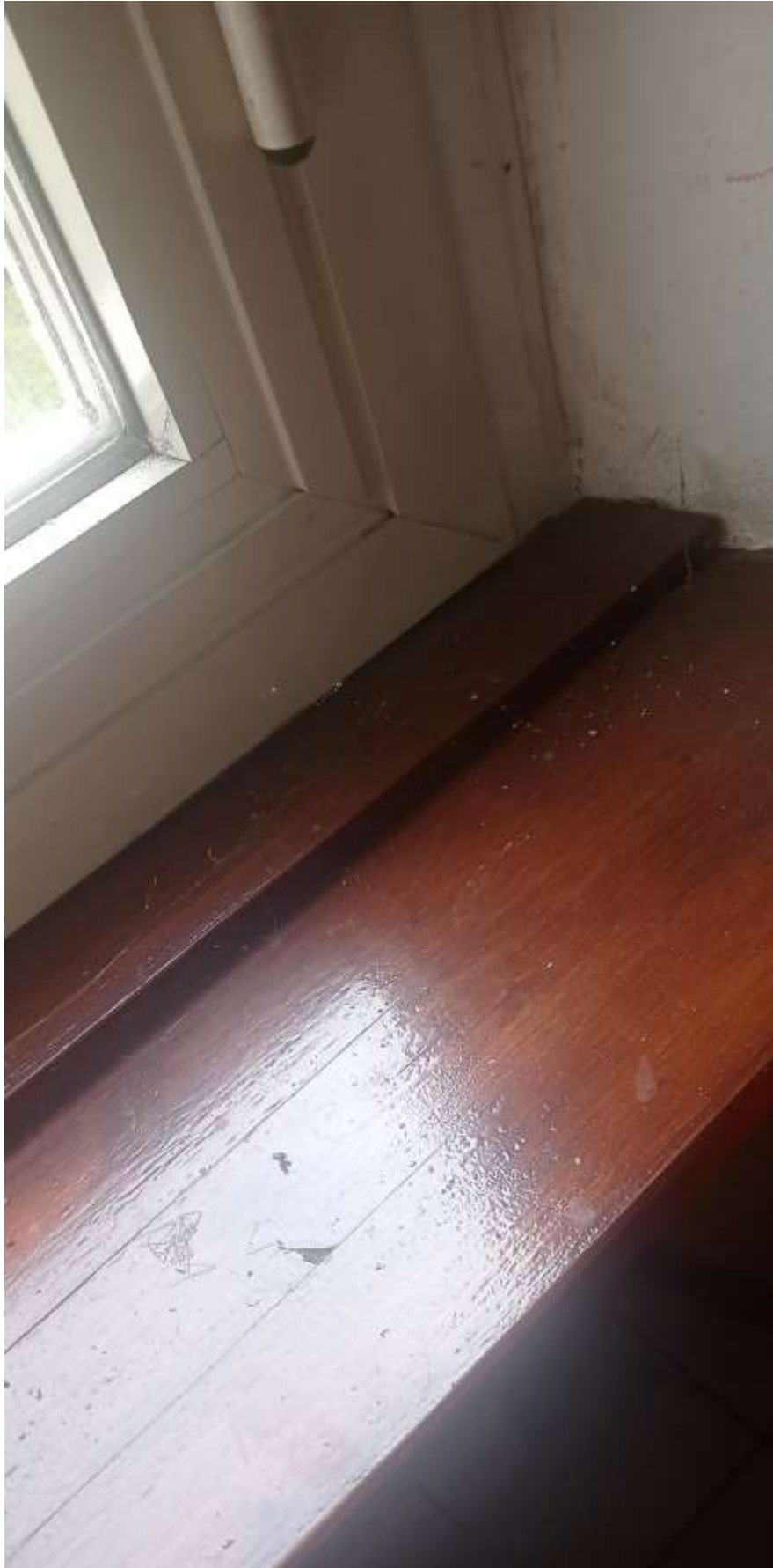
FOTO 26: particolare dei davanzali di legno interni ai vani
