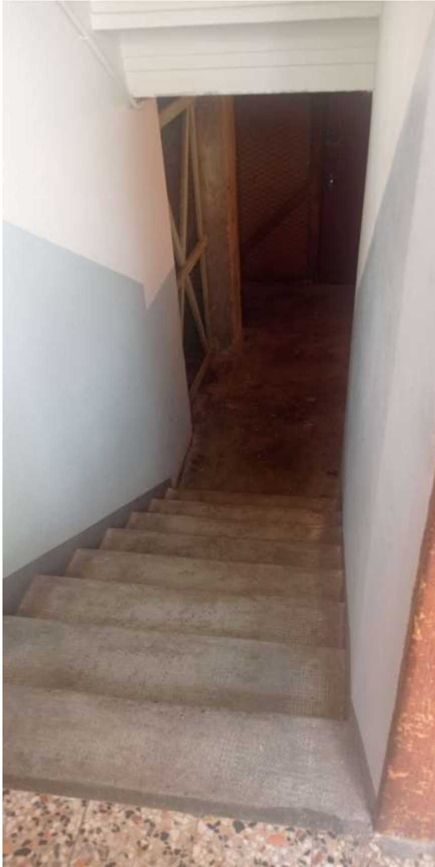
FOTO 27: la scala comune che immette alle cantine
