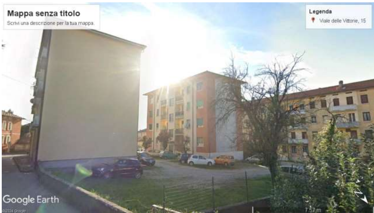
FOTO 4: facciata a Nord cieca
