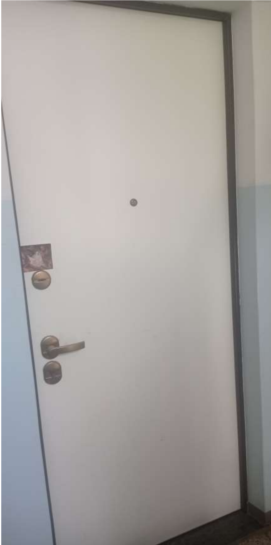
FOTO 9: la porta d'accesso all'appartamento
