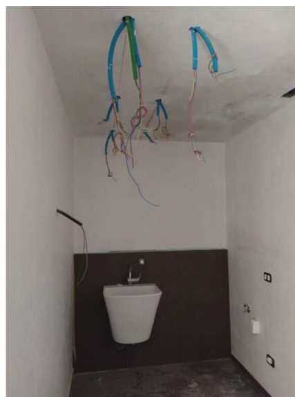
Piano terzo - lavanderia
