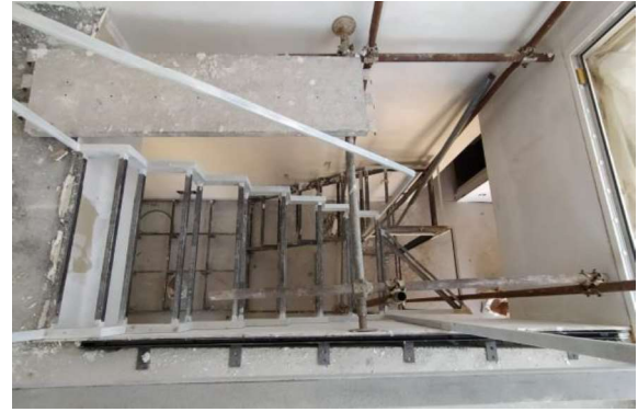
Quarto piano - scala di collegamento
