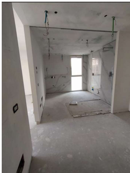
Piano terzo - bagno
