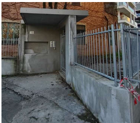
Ingresso pedonale visto dall'esterno
