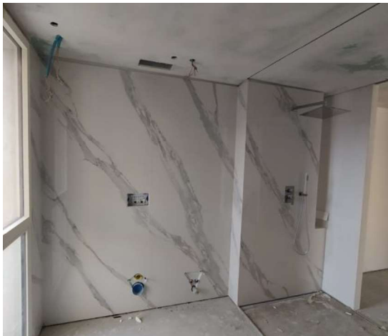
Terzo piano - bagno
