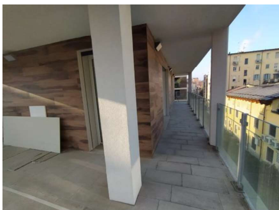
Terzo piano - terrazzo
