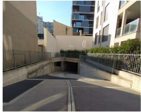
Rampa ingresso carraio
