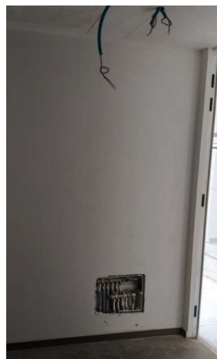
Terzo piano - lavanderia
