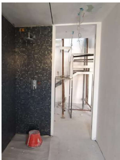
Terzo piano - bagno
