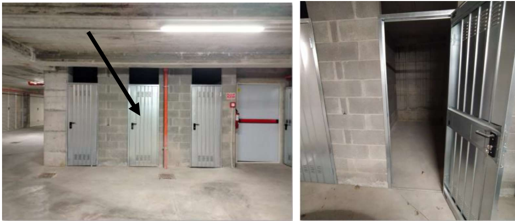
Locale ricovero biciclette/cantina Sub. 48 - piano secondo interrato
