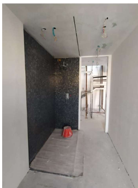
bagno - piano terzo
