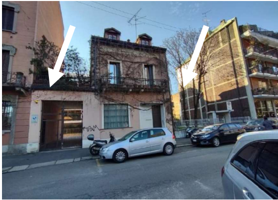
Fronte strada: accesso carraio e pedonale
