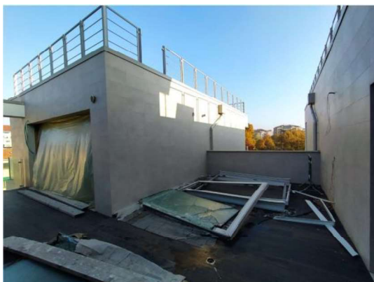
Lastrico solare vista dal piano quarto
