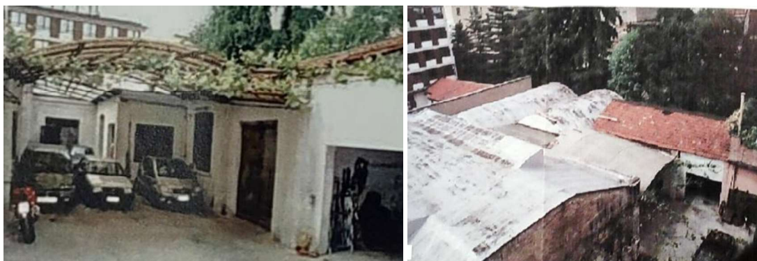
Fotografia del lotto antecedente ai lavori
