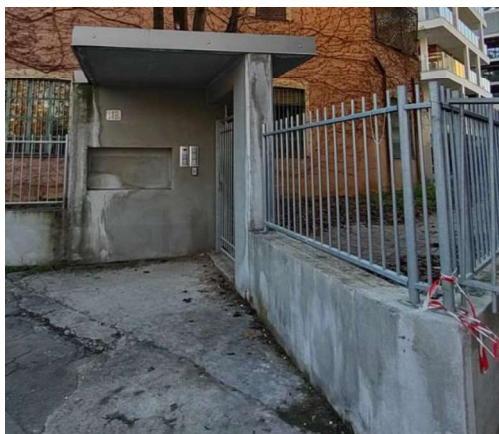
Ingresso pedonale visto dall'esterno
