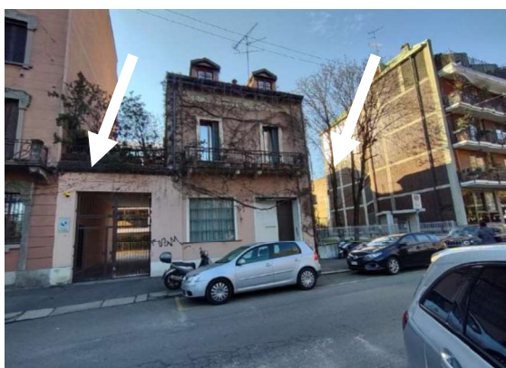
Fronte strada: accesso carraio e pedonale
