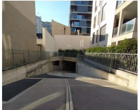
Rampa ingresso carraio
