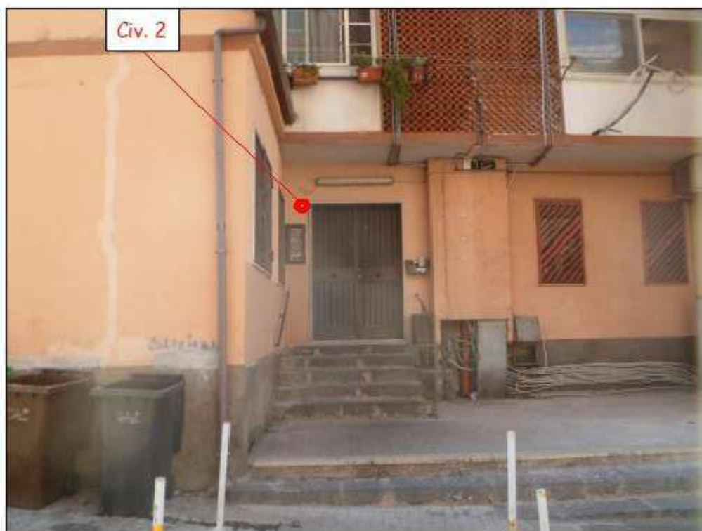
Foto n.3 - Prospetto Nord intero edificio - Civico n.2
