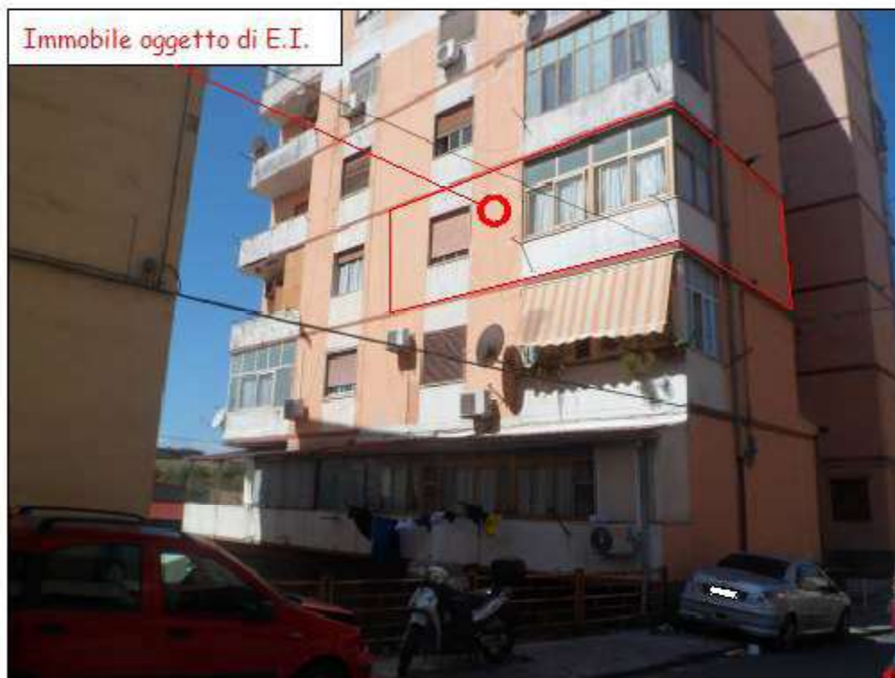
Foto n.2 - Prospetto Nord e Ovest intero edificio
