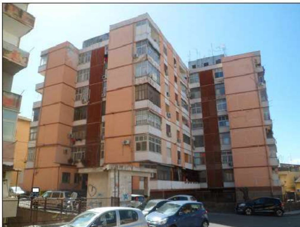
Foto n.1 - Prospetto Sud ed Est intero edificio- Ingresso da via Goito
