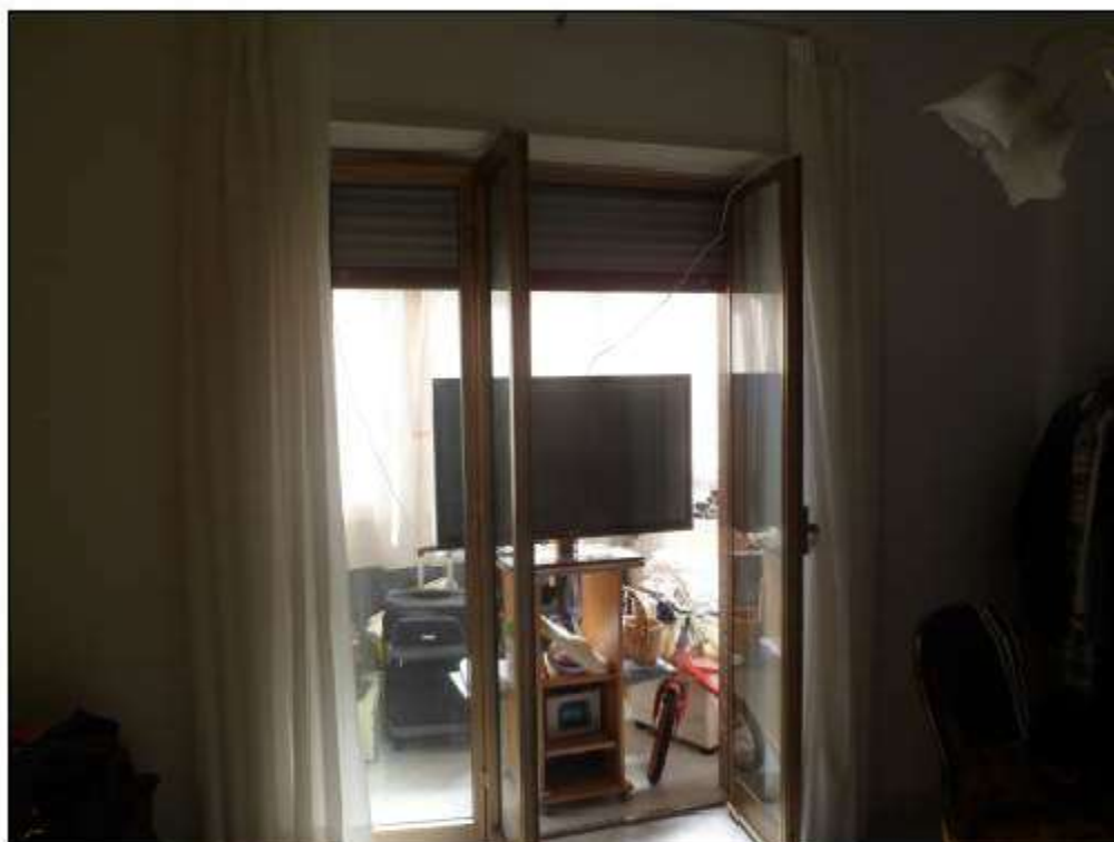
Foto n.21 - Vano 2 - Porta-finestra di accesso alla Veranda
