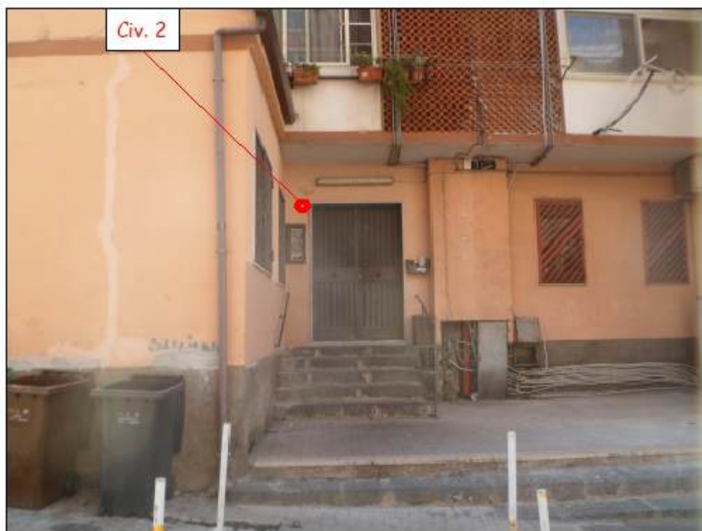
Foto n.3 - Prospetto Nord intero edificio - Civico n.2
