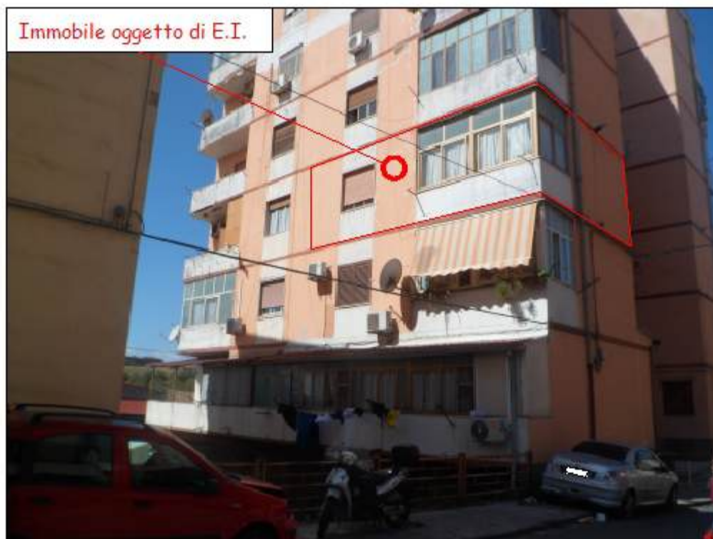
Foto n.2 - Prospetto Nord e Ovest intero edificio
