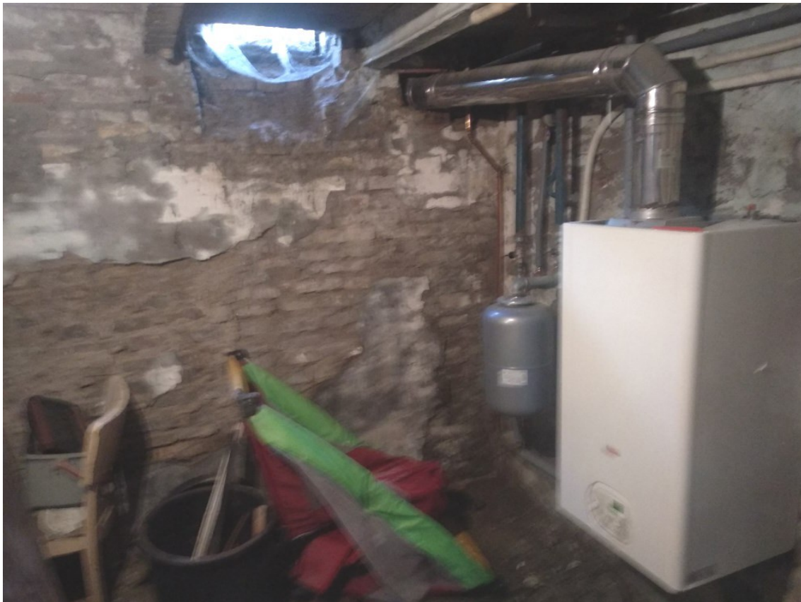
FOTO 09 – interno – piano interrato
