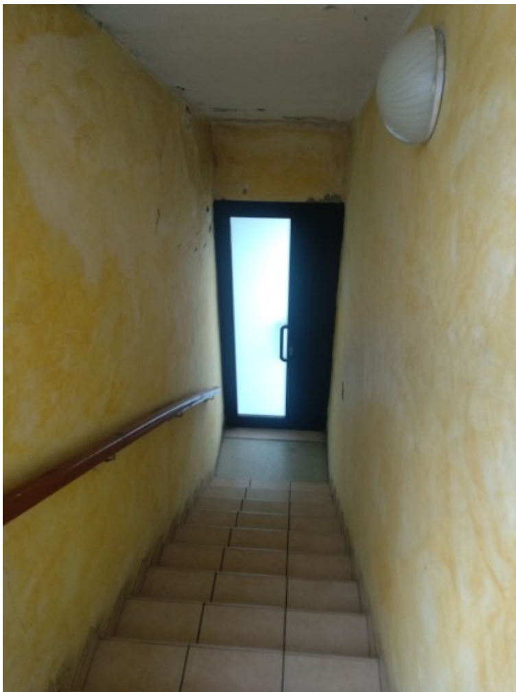
FOTO 15 – interno- scala accesso piano primo
