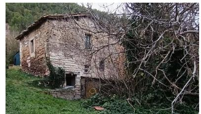
L'immobile si presenta in evidente stato di degrado, il corpo principale risulta parzialmente crollato pertanto non è possibile accedere. Ha strutture portanti in muratura e solai in legno e laterizio. Si sviluppa su due piani con finiture grezze, al piano interrato presenta pavimentazione in terra battuta; le dimensioni lorde per ogni piano sono di 57,30 metri quadri, completano l'unità una tettoia di 9,30 metri quadri lordi, una capanna ad uso
