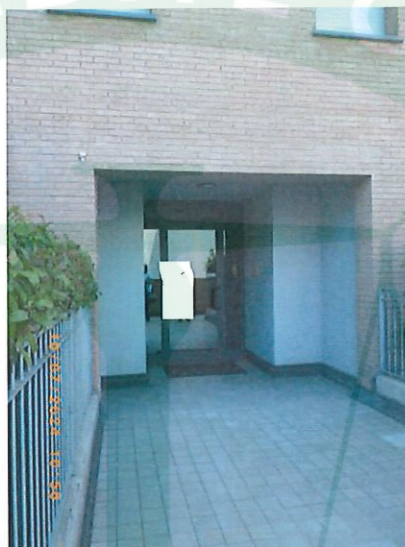
Ingresso al condominio, lato Ovest
