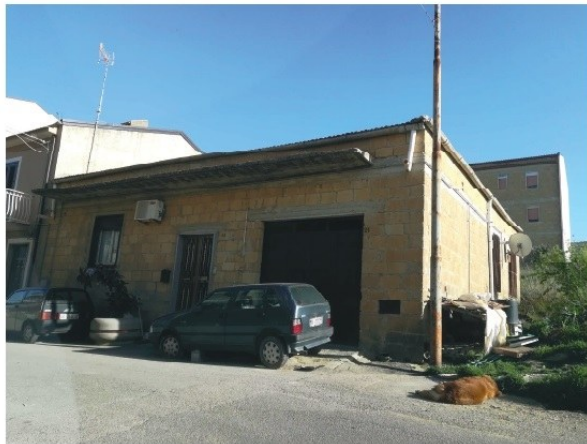
Figura 1. Fabbricato ubicato in Pietraperzia (EN) via E. Montale s.n.c.
