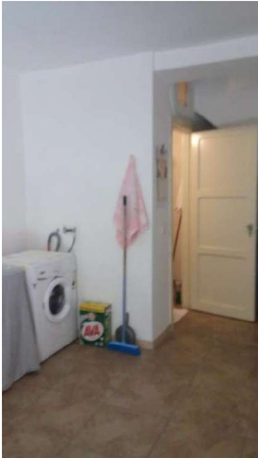
Foto 5 – garage (foglio14 particella597 sub1)
