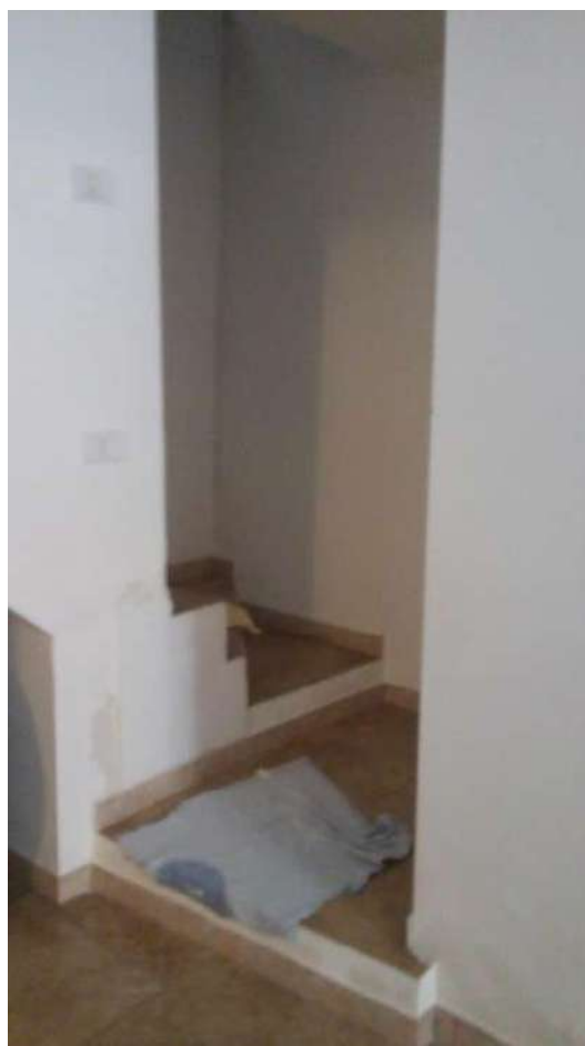
Foto 4 – vano scala (foglio14 particella597 sub1)
