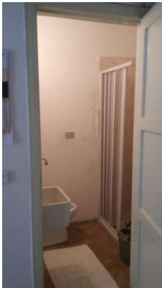
Foto 8 – wc garage (foglio14 particella597 sub1)
