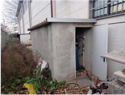
retro fabbricato principale
