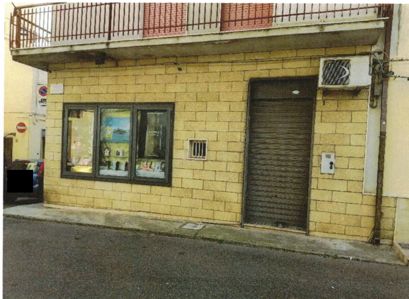
Foto n. 3 – particolare prospetto via Legnago
