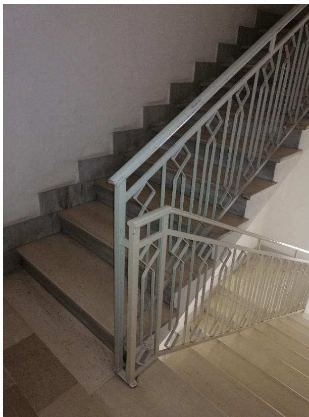
Foto n. 4 – vano scala interno
