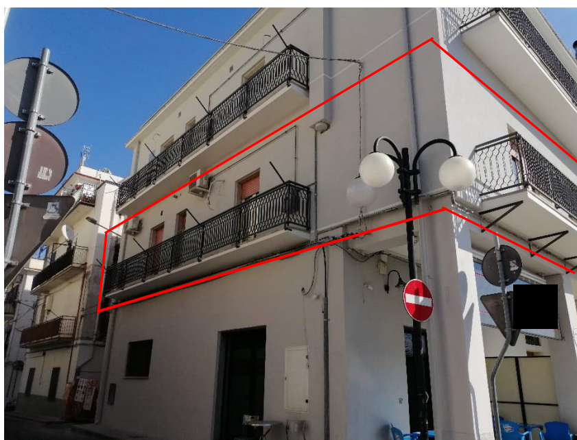
Foto n. 2 – prospetto via Salasco
