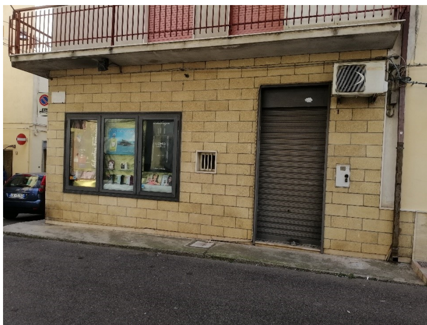
Foto n. 3 – particolare prospetto via Legnago
