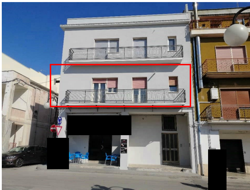
Foto n. 1 – prospetto prospiciente via Torino
