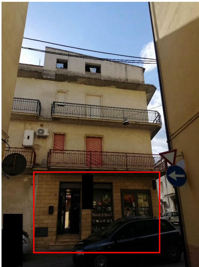
Foto n. 2 – prospetto via Risorgimento
