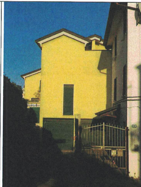
Foto n°5: Facciata sud subb. 28 e 20
