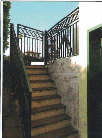
Foto n°6: Scala di accesso dal P.Terra al P.Primo
