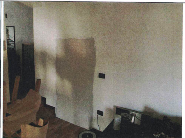
Foto n°31: Chiusura del passaggio ad ovest con Sub 29
