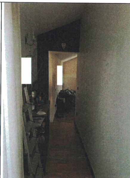
Foto n°25: Porzione di corridoio verso soggiorno
