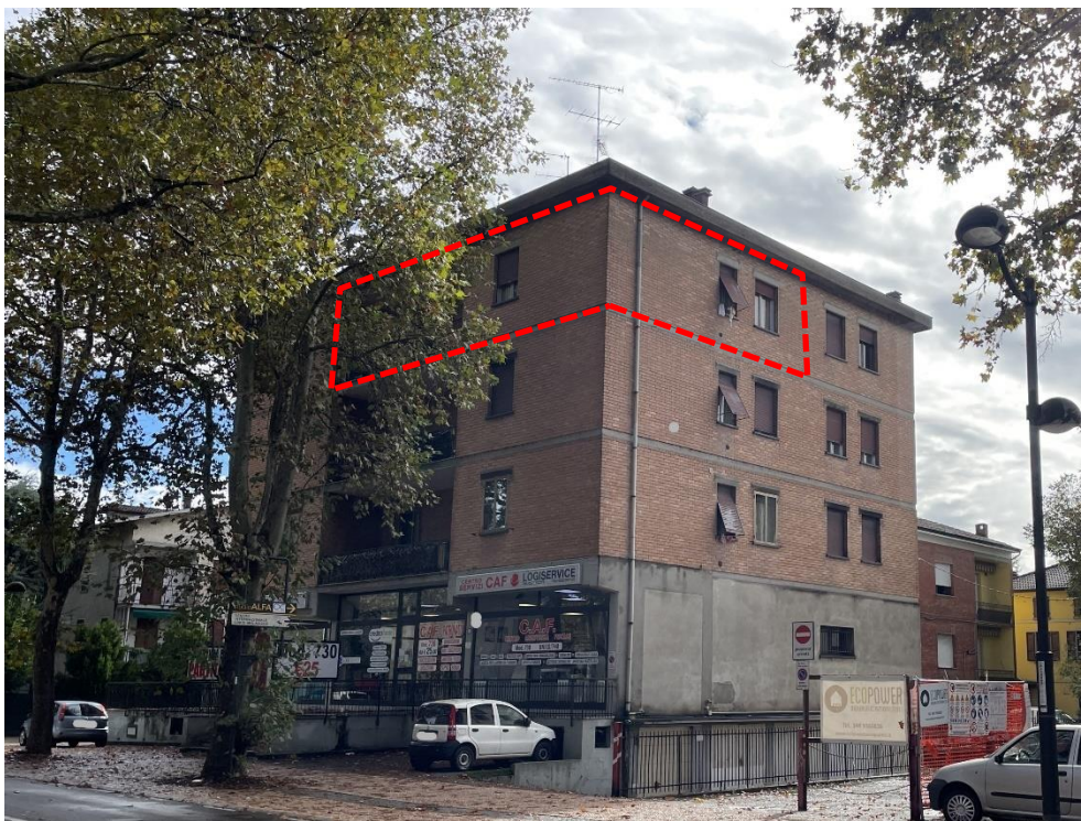
Foto 2 – Prospetto Nord - Est
