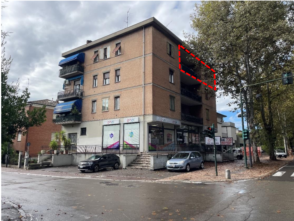
Foto 1 – Prospetto Est – Ingresso al fabbricato dalla pubblica via
