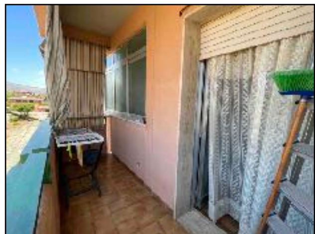
Fig.21 Balcone della cucina
