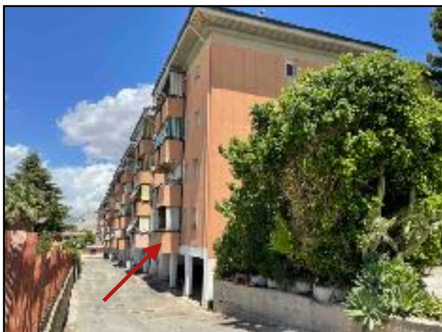
Fig.11 Fronte su via Mattarella
