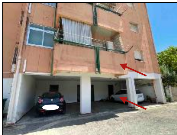
Fig.35 Appartamento e sottostante cantina
