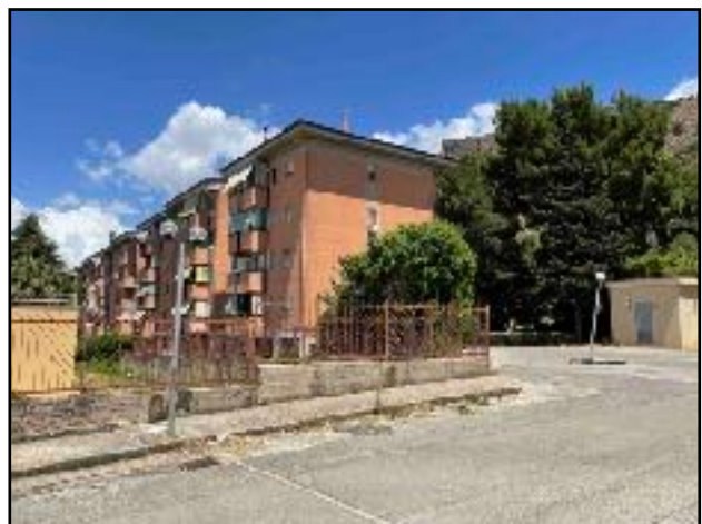
Fig.10 Testata sud-ovest del fabbricato
