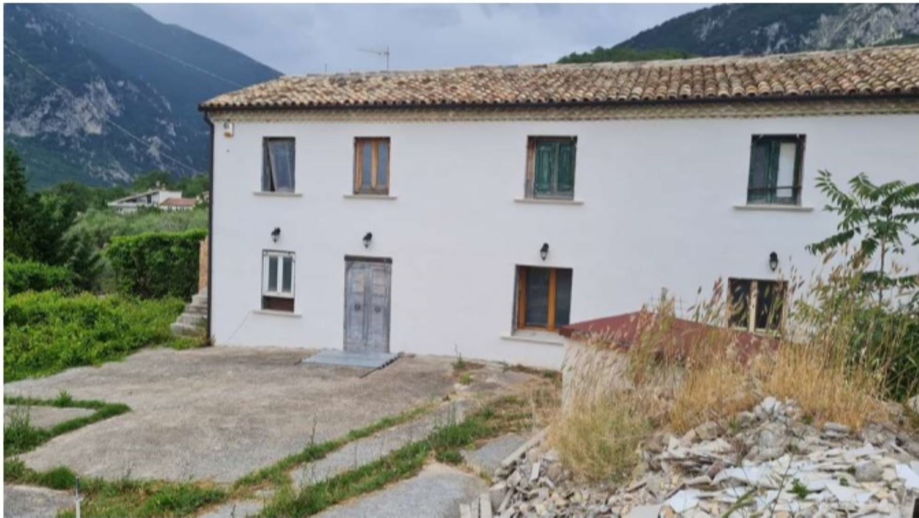
F1) Vista dell'edificio lato est.
