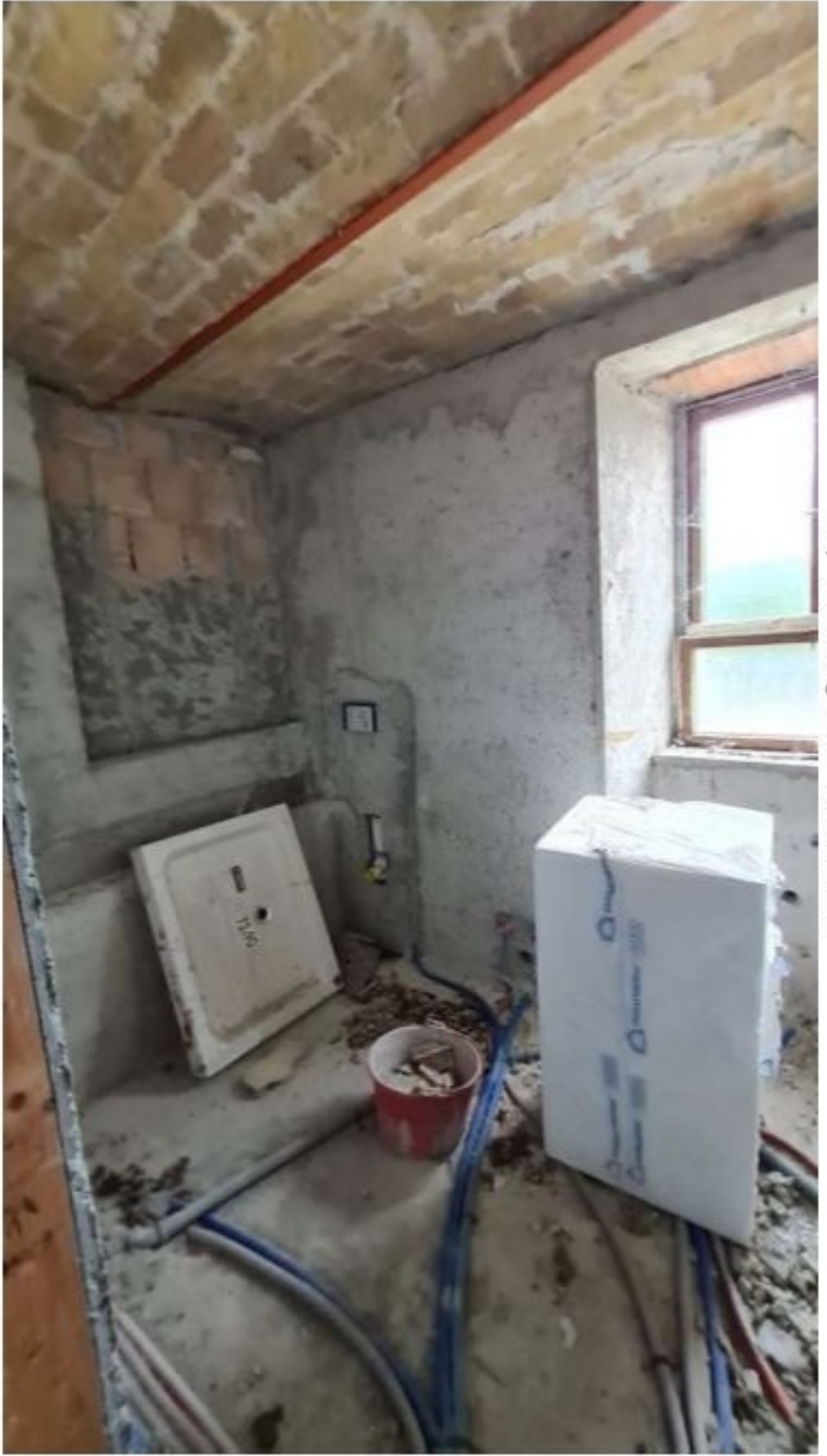
F3) Area bagno, in costruzione.
