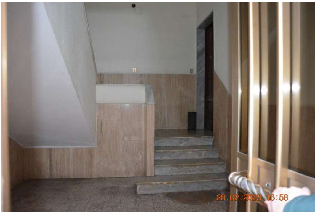
FOTO N. 2 - Piano Terra Ingresso fabbricato
