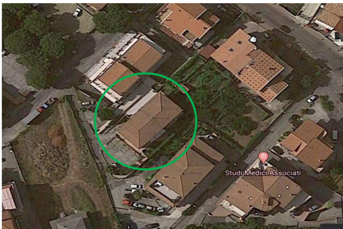
Edificio identificato con la particella n° 582
