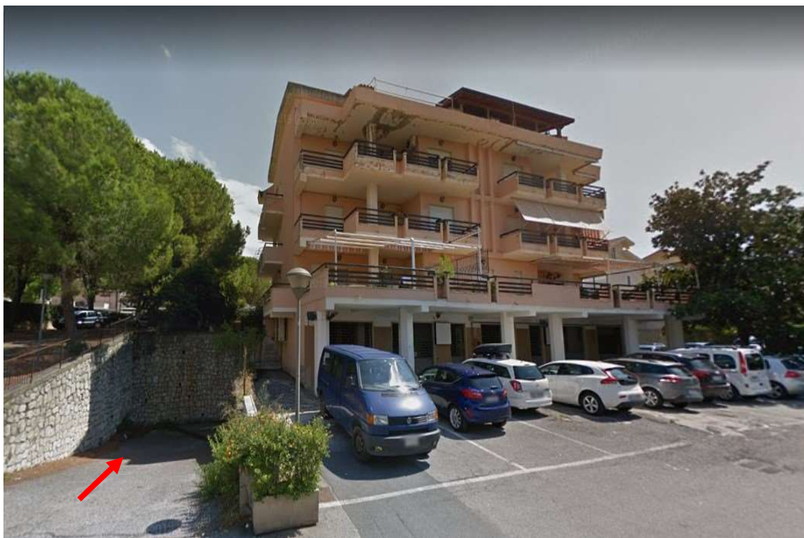
Vista prospettica lato nord dell'edificio "A" contraddistinto con la particella n° 299 con l'indicazione del punto di accesso che conduce verso l'interrato del medesimo edificio, in cui sono ubicate le due autorimesse oggetto di
