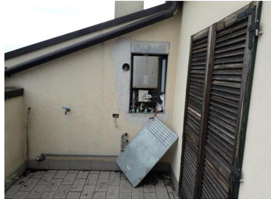
L'appartamento internamente è in buono stato, mentre devono essere sostituite le persiane (fatiscenti e con elementi mancanti) e sistemato con opere di pulizia e manutenzione il balcone. Non è stato verificato il funzionamento della caldaia, che durante il sopralluogo è stata trovata priva del coperchio protettivo.
